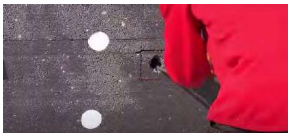
Installatie van een op maat gemaakt blok voor het bevestigen van de lamp, alarm, besvestigen
