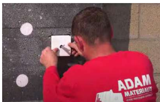
Doorgang van de elektrische kabel naar EPS Adam Materiaux
