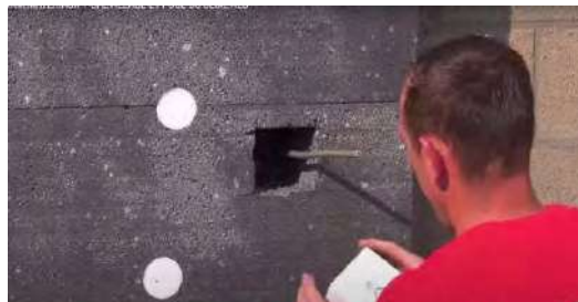
Doorgang van de elektrische kabel naar EPS Adam Materiaux
