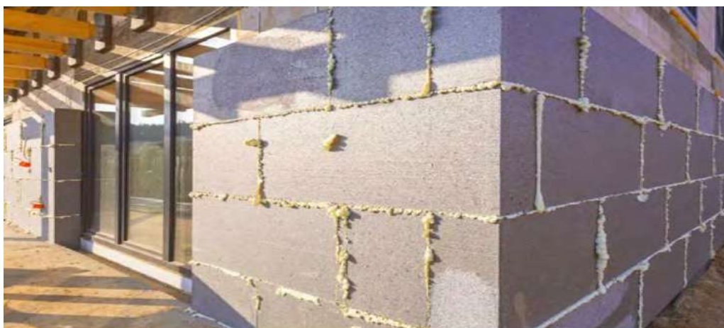
Installatie van Adam Matériaux EPS-isolatie in een trapsgewijs patroon, op de juiste manier
