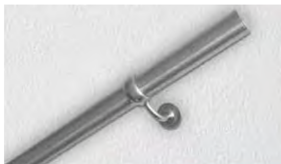
Installatie van leuningen bevestigd aan de UMP-blokken na het aanbrengen van het pleisterwerk
