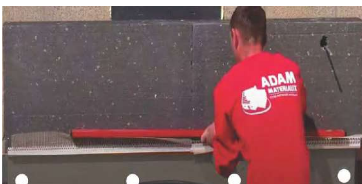
Installatie van EPS 032 Adam Materials-isolatie - EPS HD Adam Materiaux
