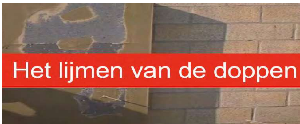
Het lijmen van de doppen vóór het coaten van de Adam Matériaux HD EPS-panelen
