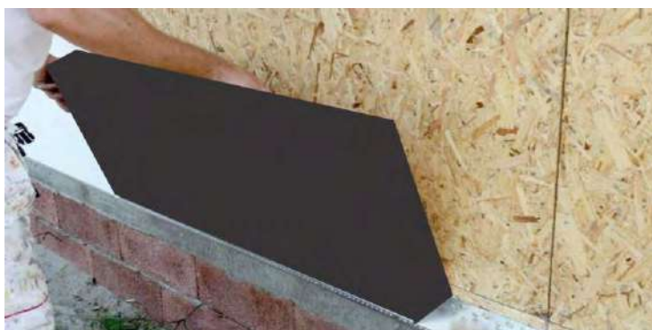
ADAM Materiaux EPS HD collage met Adam Materiaux PUR-schuim op houten gevel
