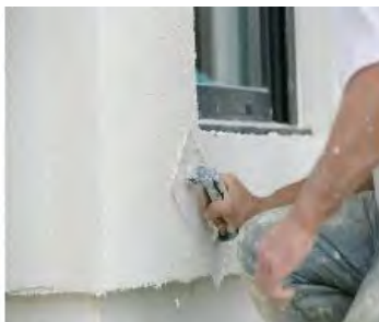
Het aanbrengen van pleisterwerk met Kubala 0300
