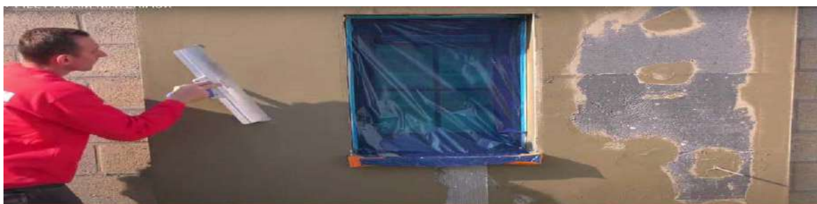
Aanbrengen van Adam Materiaux lijm op het Adam Materiaux versterkingsnet
