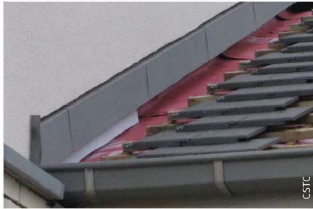
A. Ansicht vor dem Verlegen der Dacheindeckung
