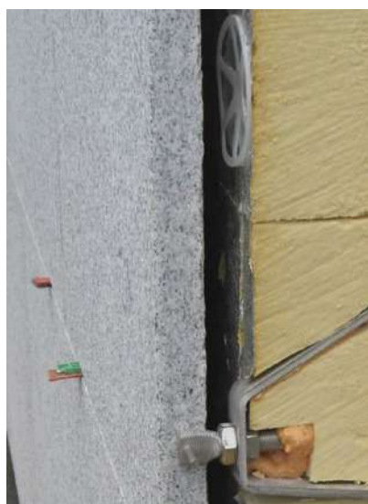
Naturstein geklammert und Basisdämmung zum Abschluss des Sockels.
