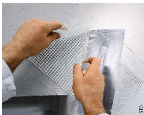
- Installation eines Adam Matériaux® Bewehrungsgewebes in der Ecke eines 300X300mm Feldes (HANDKERCHIEFS)
