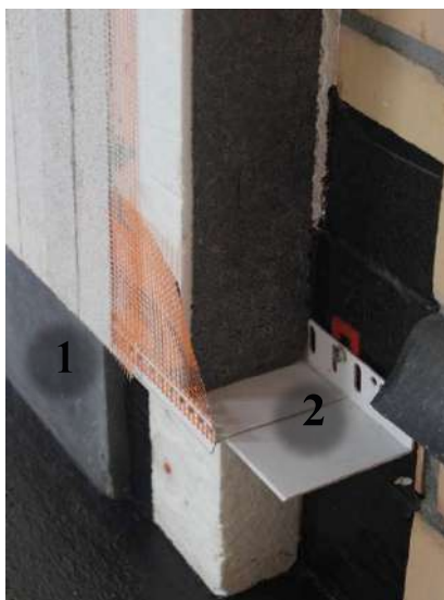
1- Platte auf Spritzisolierung geklebt 2- LW66 Eckkomplex
