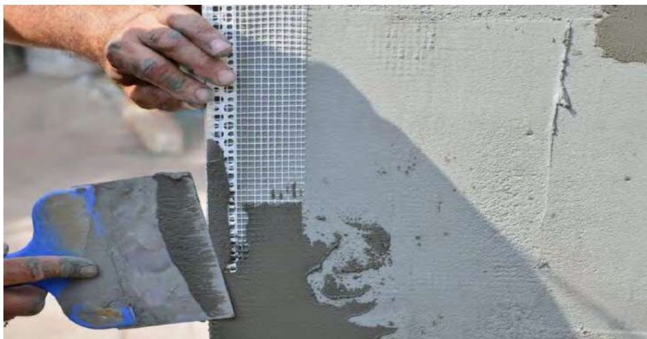
Кутовий захист LCL, встановлений на фасаді перед нанесенням штукатурки Adam Matériaux
