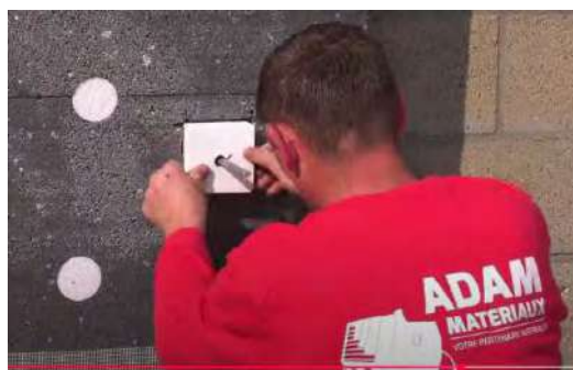
Встановлення блоку VARIQ або VARIR
