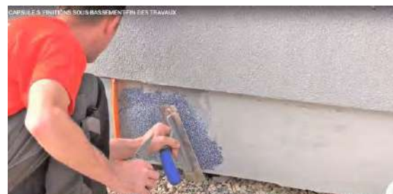
Монтаж штукатурки підвалу Adam Materiaux
