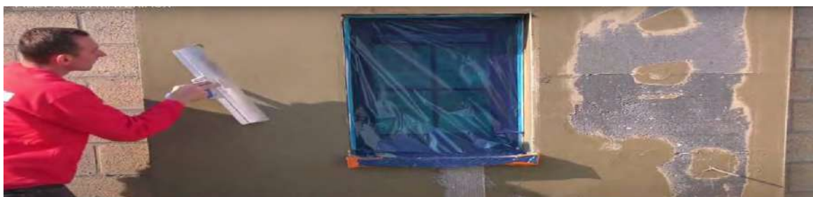
Змішування армуючої сітки Adam Matériaux у сірому або білому клеї Adam Matériaux
