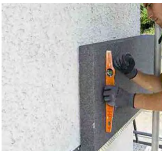
Використання рівня для укладання пінополістиролу Adam Matériaux
