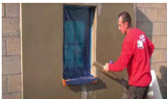
Розгладжування сірого або білого штукатурного клею Adam Matériaux© завершено.
