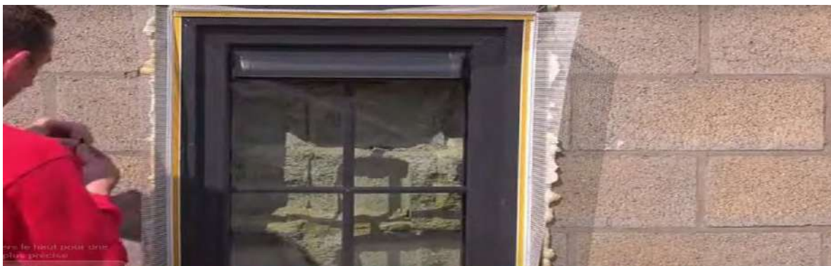
Розміщення самоклеючих кутових кронштейнів LS-VH 06 до віконної рами по периметру вікна. Встановлення 6-міліметрових кутових кронштейнів LS-VH 06 на відстані щонайменше 2 см від краю віконної рами.
