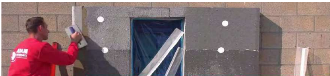
Фіксація кута 10+10 см за допомогою клею Adam Materiaux
