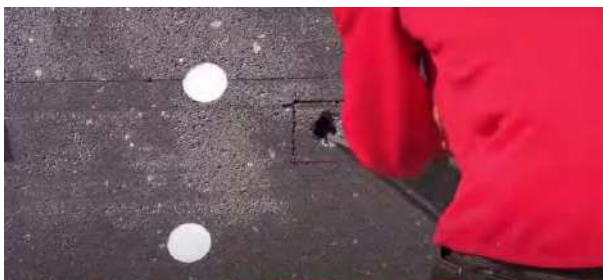
Встановлення виготовленого на замовлення блоку для монтажу лампи, сигналізації, кріплення тощо.
