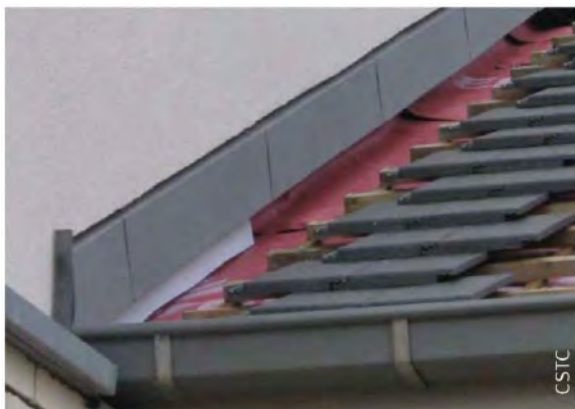
А. Вигляд до встановлення покрівлі
