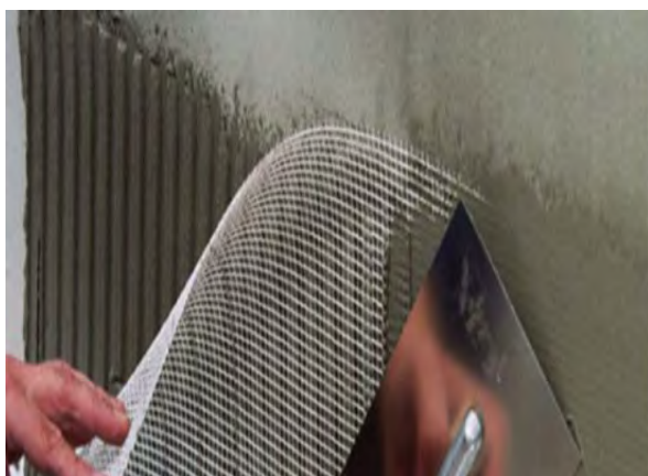
Змішування армуючої сітки Adam Matériaux у сірому або білому клеї Adam Matériaux
