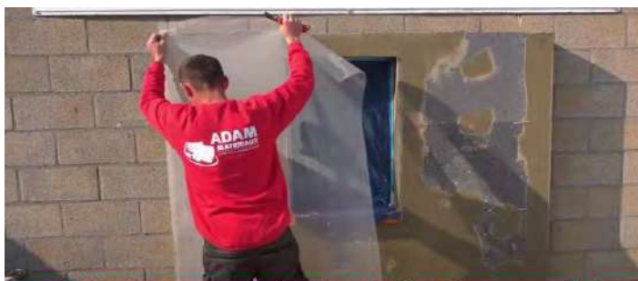
Різання та укладання смуг армуючої сітки Adam Matériaux, дотримуючись мінімального нахлесту 10 см між смугами
