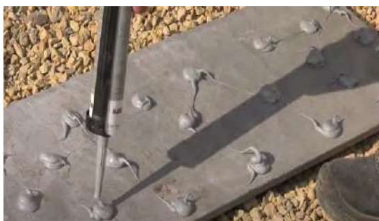
Монтаж 2-компонентних силіконових прокладок для приклеювання блакитного каміння
