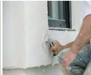
Затирка штукатурки з Kubalala 0300
