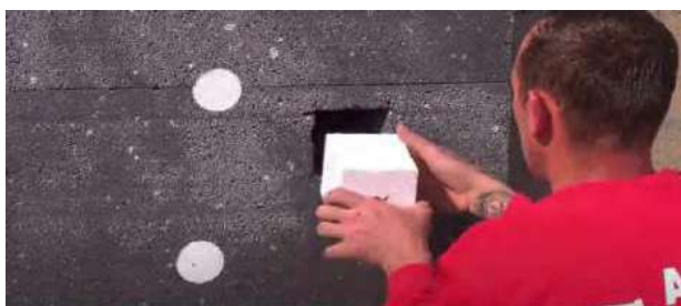
Прокладання електричного кабелю через блок EPS Adam Materiaux
