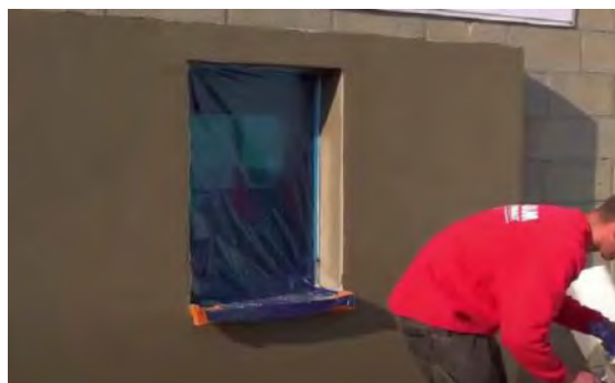
Укладання армуючої сітки та сірого або білого клею
