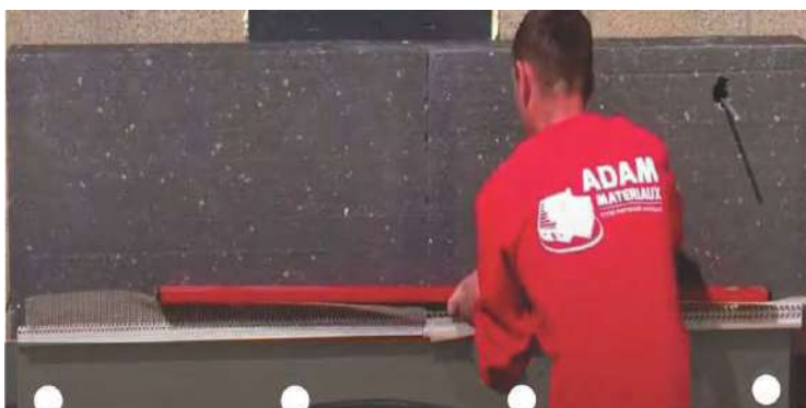
Встановлення ізоляції EPS 032 від Adam Matériaux - EPS HD від Adam Matériaux
