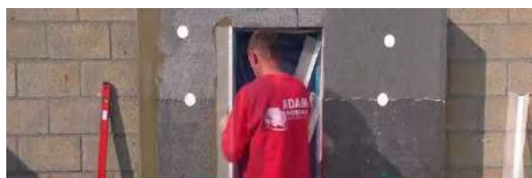
Вирізання та встановлення кутника 10+10 см на кутах вікна, регулювання рівня кутника 10+10 см
