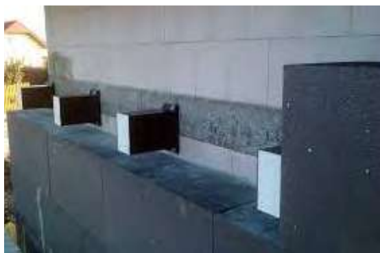
Встановлення поручнів, закріплених на блоках УМП, після нанесення штукатурки
