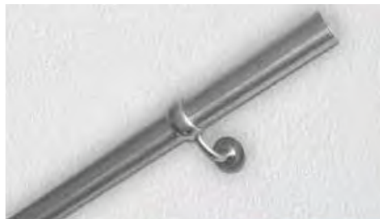
Встановлення поручнів, закріплених на блоках УМП, після нанесення штукатурки
