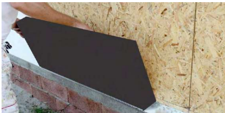
Склеювання EPS HD з піною Adam Matériaux PUR на дерев'яному фасаді
