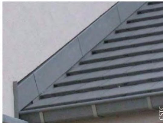
В. Вигляд після встановлення покрівлі.
