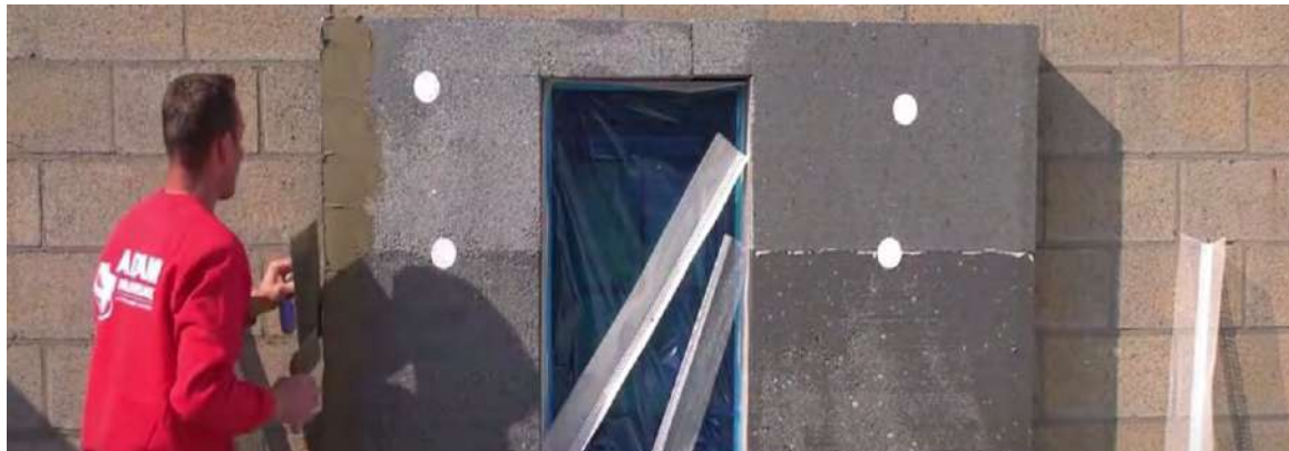
Нанесення клею Adam Matériaux на кут фасаду
