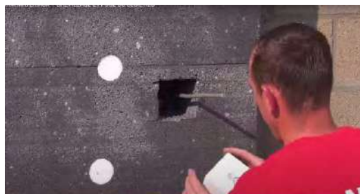
Прокладання електричного кабелю через блок EPS Adam Materiaux
