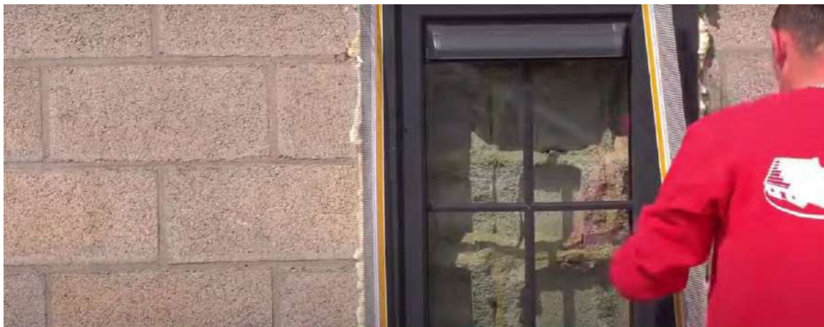
Встановлення кутових кронштейнів LS-VH 06 до віконної рами по периметру вікна. Встановлення кутового кронштейна LS-VH 06 6 мм на відстані щонайменше 2 см від краю віконної рами.
