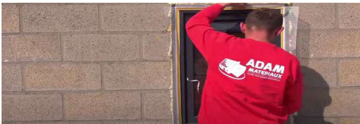
Встановлення кутових кронштейнів LS-VH 06 до віконної рами по периметру вікна. Встановлення кутових кронштейнів LS-VH 06 діаметром 6 мм на відстані щонайменше 2 см від краю віконної рами.
