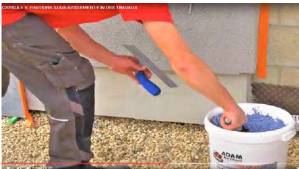
Монтаж штукатурки підвалу Adam Materiaux
