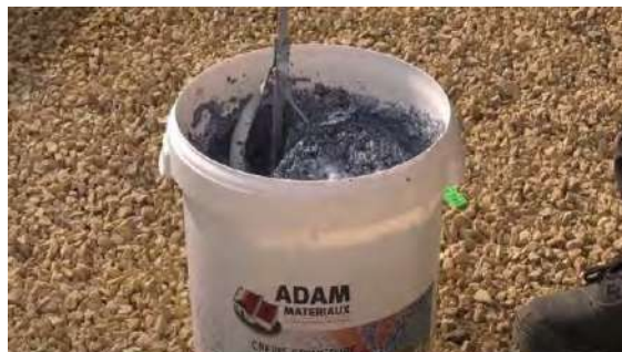
Обв'язок змішування штукатурки перед початком робіт
