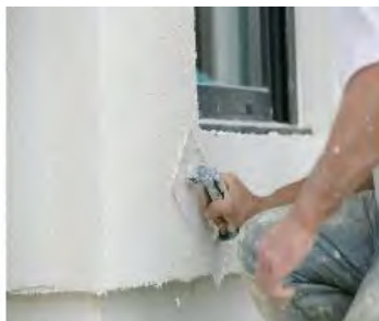
Het aanbrengen van pleisterwerk met Kubala 0300
