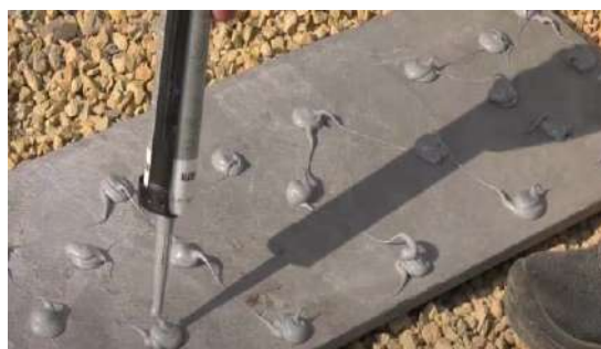
Montaż podkładek silikonowych 2-składnikowych do klejenia kamienia niebieskiego
