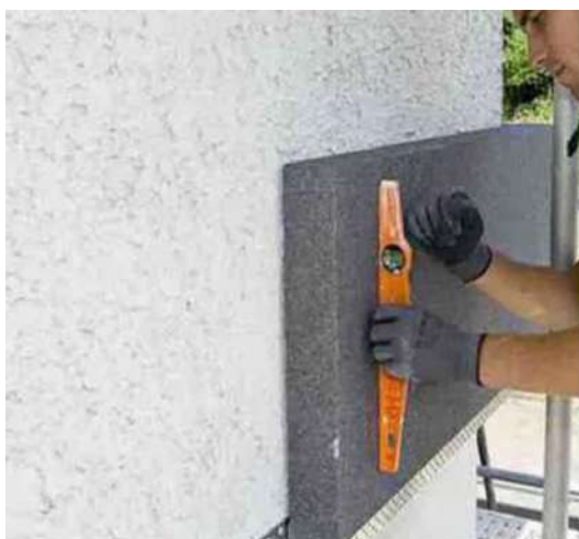
Układanie Adam Materiaux EPS przy użyciu poziomicy
