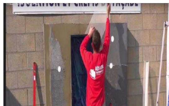
Umieszczenie tkanki wzmacniającej w 4 rogach ramek, sklejenie klejem Adam Materiaux
