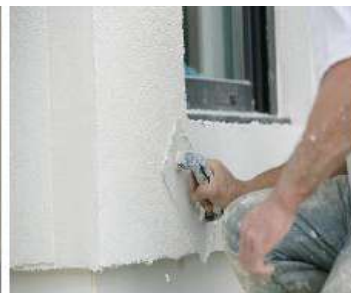
Zacieranie tynku za pomocą Kublala 0300
