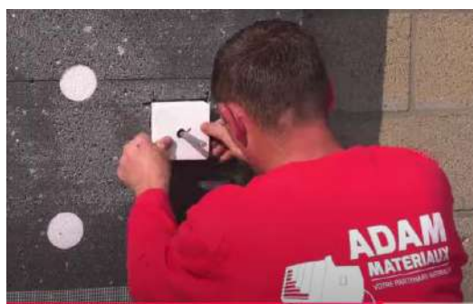
Montaż bloku VARIQ lub VARIR
