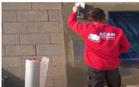
Używając tynku Kubala 0202 6x6mm
