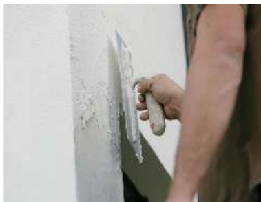
Tynkowanie masami Kubala 0401 i 0473
