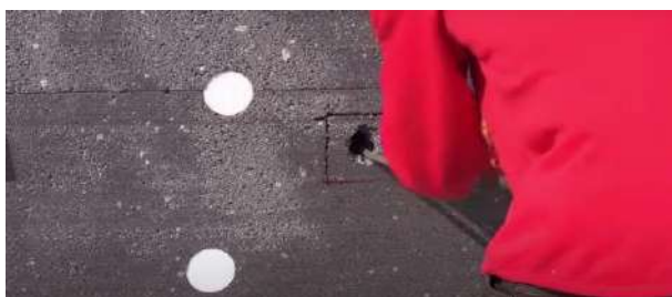
Montaż bloku wykonanego na zamówienie do mocowania lampy, alarmu, elementu mocującego itp.
