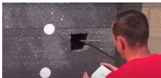
Przeprowadzenie kabla elektrycznego przez blok EPS Adam Materiaux
