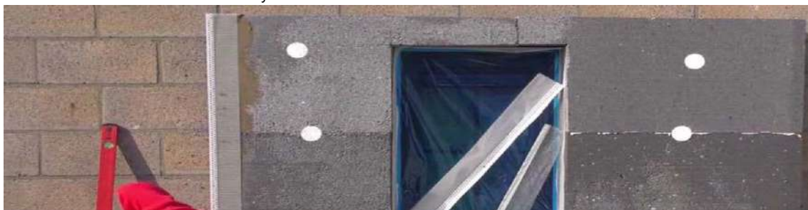
Docięcie i montaż kątownika narożnego 10+10 cm w narożnikach elewacji
