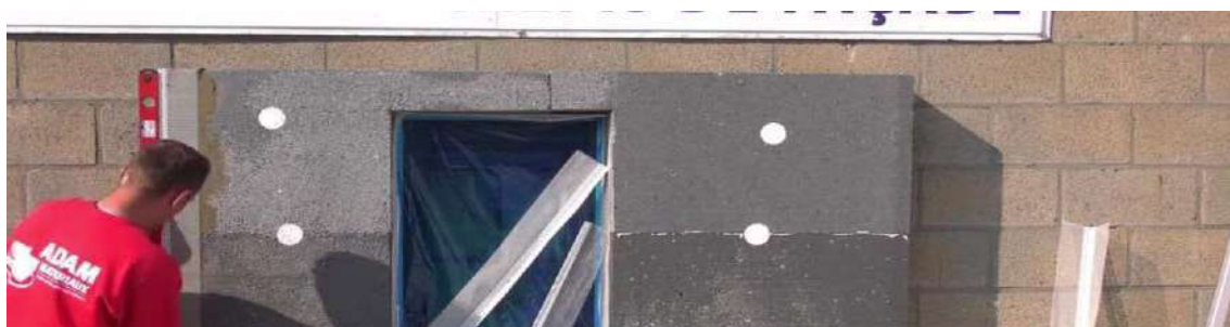
Regulacja wysokości wspornika narożnego 10+10cm
