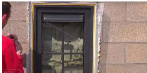
Umieszczenie samoprzylepnych narożników podwozia LS-VH 06 wokół podwozia
