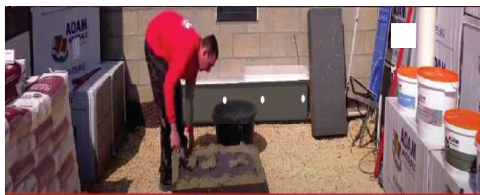
Nakładanie szarych podkładek klejowych Adam Materiaux co 10 cm w środku izolacji
