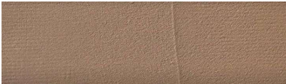
Wygląd kleju Adam Materiaux po wygładzeniu na siatce zbrojeniowej Adam Materiaux
