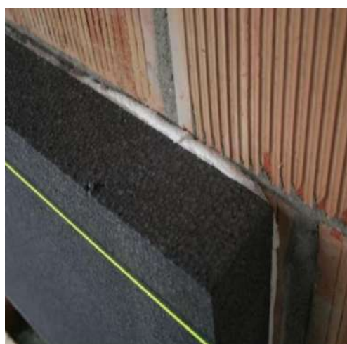
Układanie EPS za pomocą liny
