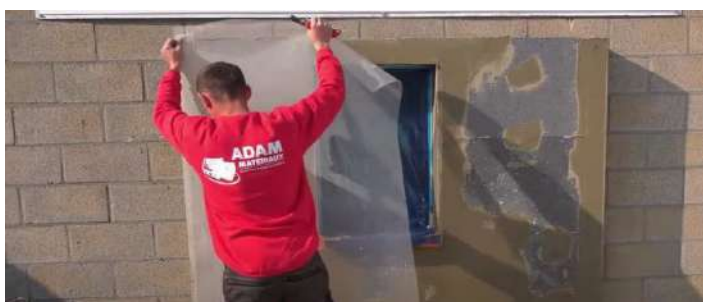
Cięcie i układanie pasów siatki zbrojeniowej Adam Materiaux, z zachowaniem min. 10 cm nakładu między pasami
