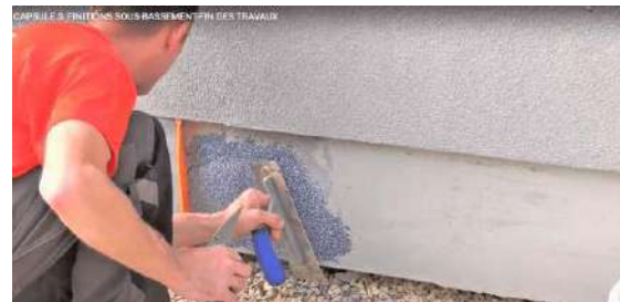
Montaż tynku piwnicznego Adam Materiaux
