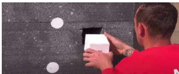
Przeprowadzenie kabla elektrycznego przez blok EPS Adam Materiaux
