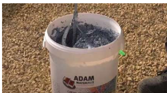
Obowiązek wymieszania tynku przed rozpoczęciem pracy
