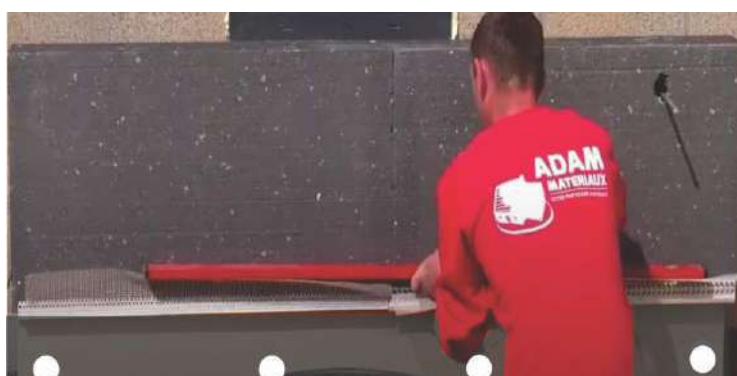
Montaż izolacji EPS 032 Adam Materiaux - EPS HD Adam Materiaux
