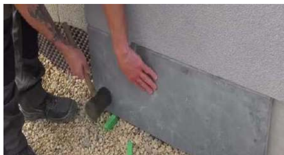
Regulacja poziomów niebieskiego kamienia
