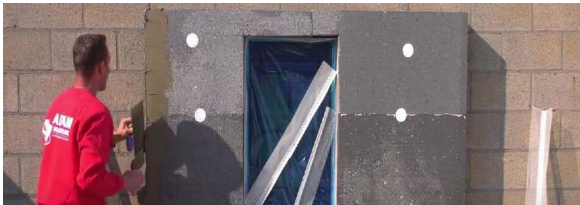
Nakładanie kleju Adam Materiaux na narożnik fasady
