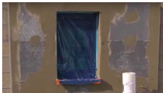
Przycięcie i montaż narożnika 10+10 cm na narożnikach okna, regulacja poziomu narożnika 10+10 cm
