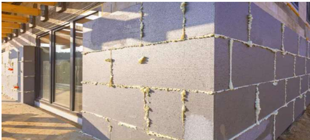
Instalarea izolației EPS Adam Matériaux într-un model eșalonat, în mod corect
