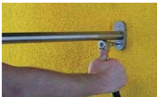
Instalarea balustradelor fixate pe blocurile UMP după așezarea tencuiei
