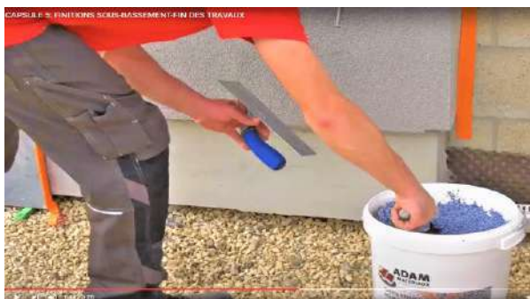
Montarea tencuiei de subsol Adam Materiaux
