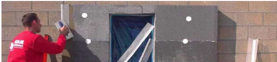
Fixarea consolei de colț de 10+10 cm cu adeziv Adam Materials
