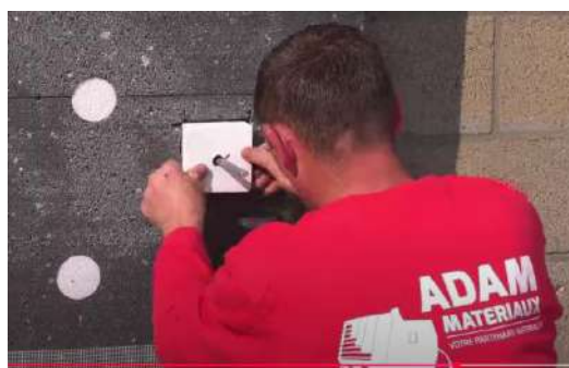
Instalarea blocului VARIQ sau VARIR
