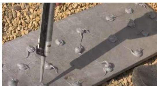
Instalarea plăcuțelor siliconice bicomponente pentru lipirea pietrei albastre
