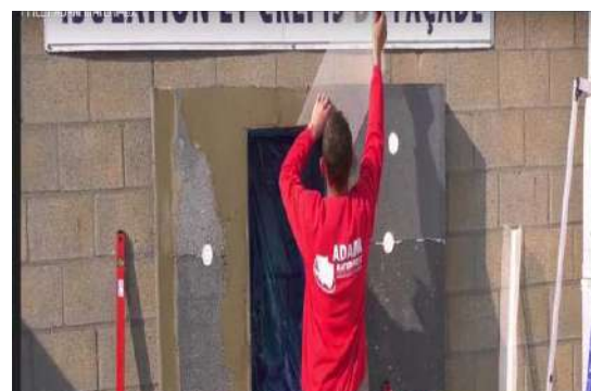
Plasarea țesăturii de armare la cele 4 colțuri ale ramelor, lipirea cu adeziv Adam Materials
