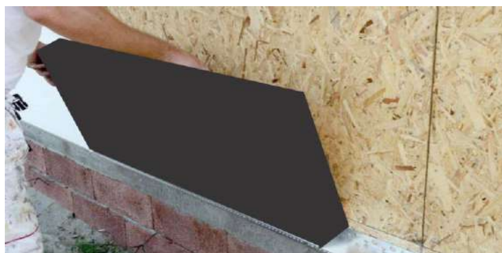
Colaj ADAM Materiaux EPS HD cu spumă PUR Adam Materiaux pe fațadă din lemn
