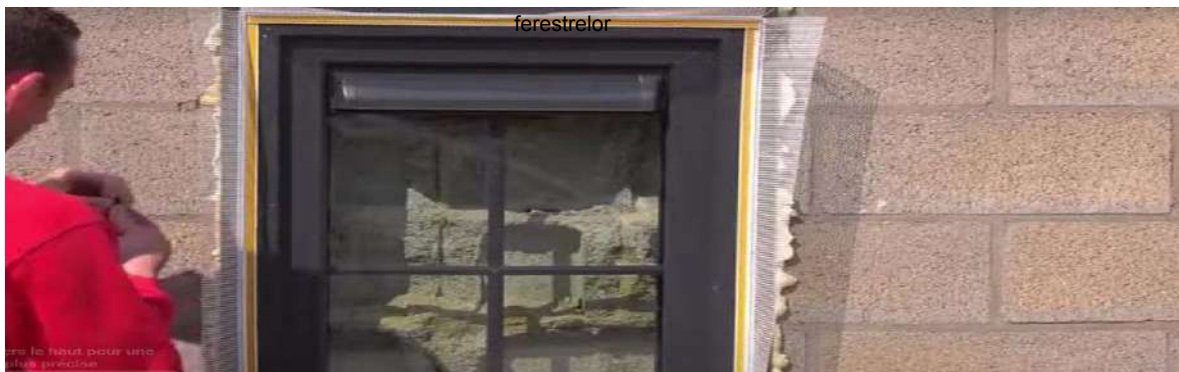
Placement des cornières contre chassis LS-VH 06 autocollantes sur le pourtour des chassiss ferestrelor
