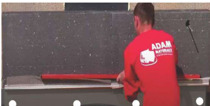
Instalare izolație EPS 032 Adam Materiaux - EPS HD Adam Materiaux
