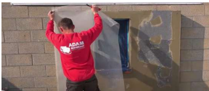
Tăierea și așezarea benzilor de plasă de armare Adam Materiaux, asigurând o suprapunere de cel puțin 10 cm între benzi
