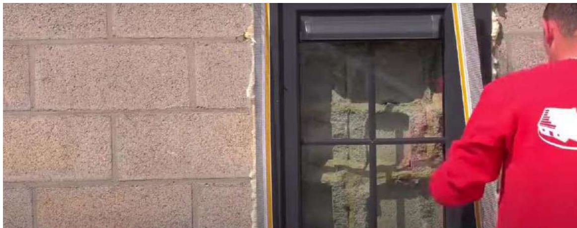
Plasarea consolelor de ramă LS-VH 06 în jurul ferestrei
