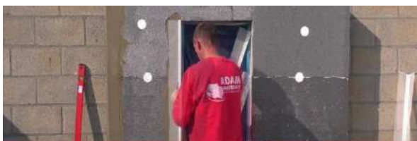
Tăierea și instalarea colțarului de 10+10 cm pe colțurile ferestrelor, reglarea nivelurilor colțarului de 10+10 cm
