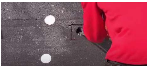
Instalarea unui bloc personalizat pentru fixarea unei lămpi, alarmă, element de fixare; ...
