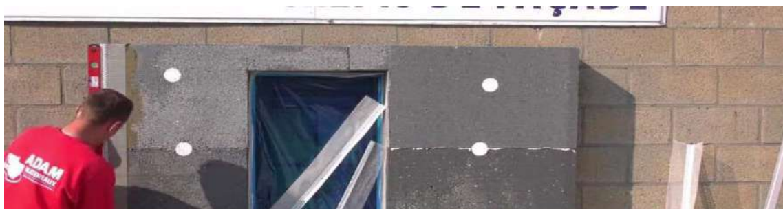
Reglarea nivelurilor consolei de colț 10+10 cm
