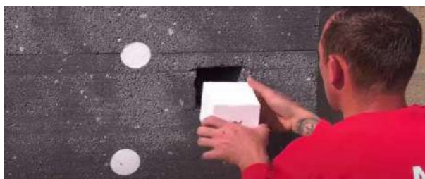
Trecerea cablului electric prin blocul EPS Adam Materiaux
