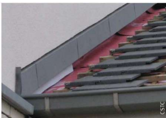
A. Vedere înainte de instalarea învelitorii acoperișului
