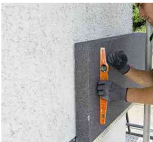
Utilizarea unei nivele pentru așezarea EPS Adam Materiaux
