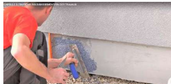
Montarea tencuiei de subsol Adam Materiaux
