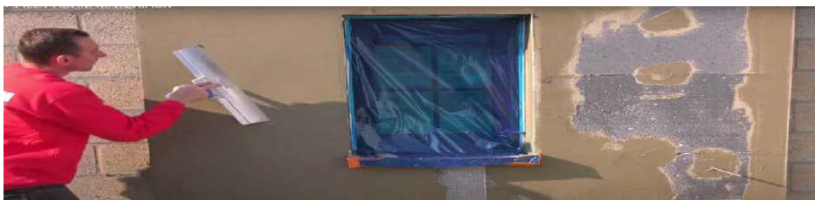
Aplicarea adezivului Adam Materiaux pe plasa de armare Adam Materiaux
