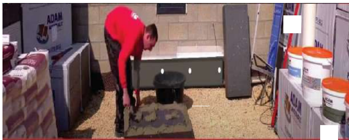
Aplicarea de plăcuțe de adeziv gri Adam Materiaux la fiecare 10 cm în centrul izolației
