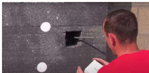
Trecerea cablului electric prin blocul EPS Adam Materiaux
