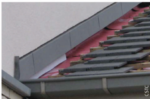
A. Vue avant la pose de la couverture
