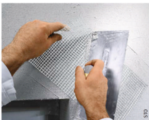
Pose d'un filet d'armature Adam Matériaux de renfort dans l'angle d'une baie 300X300mm (MOUCHOIRS)
