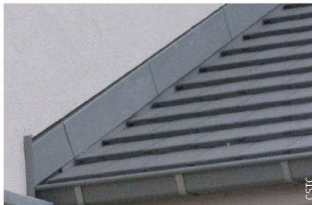
B. Vue après la pose de la couverture
