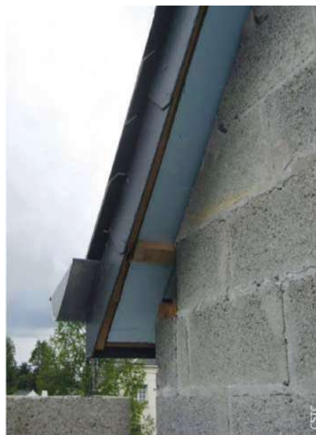
Aansluiting op de zijrand van een schuin dak (zicht op de aangebrachte isolatie vóór de gevelwerkzaamheden)
