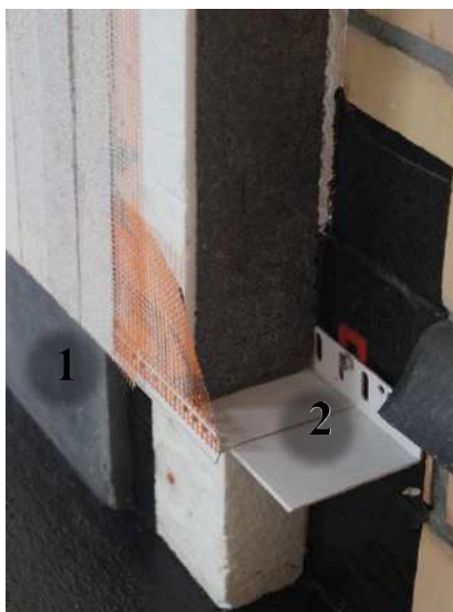
1- Plint verlijmd op de plintisolatie 2- LW66 hoekcomplex
