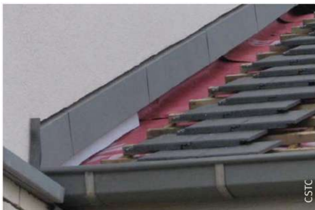
A. Bekijken voor het leggen van de dakbedekking
