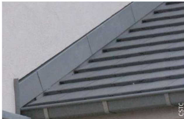
B. Bekijk na installatie van de afdekking. Aansluiting van de Adam Matériaux ETICS aan het begin van een schuin dak
