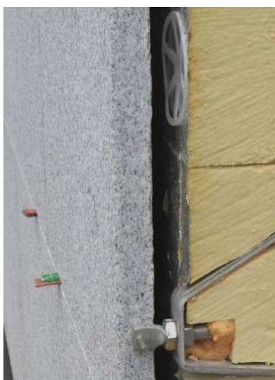
Natuursteen geniet en basisisolatie voor de afwerking van de basis.
