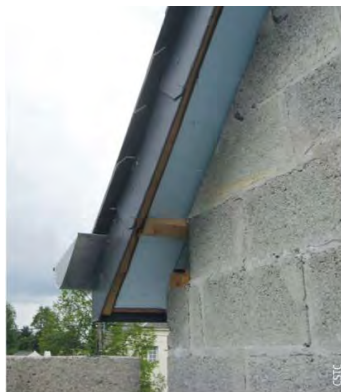
Raccord à la rive latérale d'une toiture à versants (vue de l'isolant interposé avant les travaux de façade).
