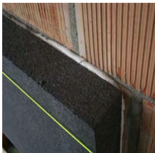
Utilisation d'une corde pour la pose de l'EPS
