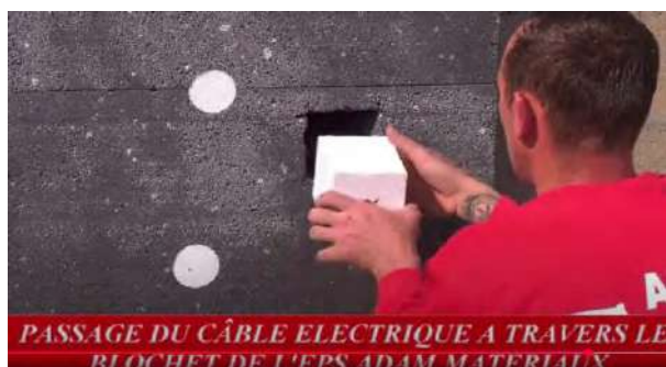
Pose du blochet VARIQ ou VARIR
