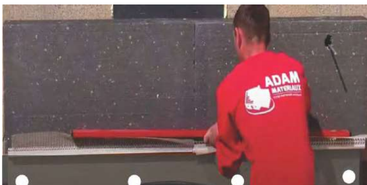
Pose de l'isolant EPS 032 Adam Matériaux - EPS HD Adam Matériaux
