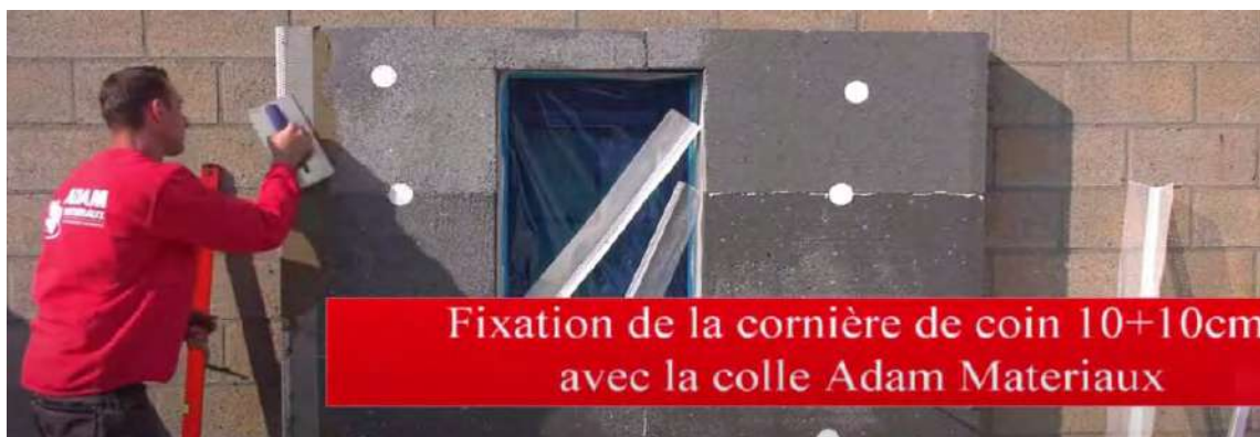
Fixation de la cornière LK PVC Premium 10x10cm au coin de la façade avec la colle grise ou blanche Adam Matériaux
