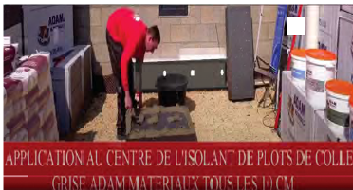
Pose de colle grise Adam Matériaux pour le collage de l'EPS Adam Matériaux
