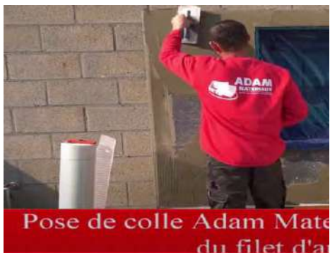
Utilisation de la plâtresse Kubala 0202 6x6mm
