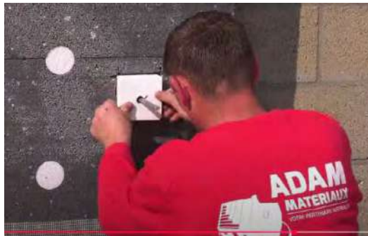
Pose du blochet VARIQ ou VARIR
