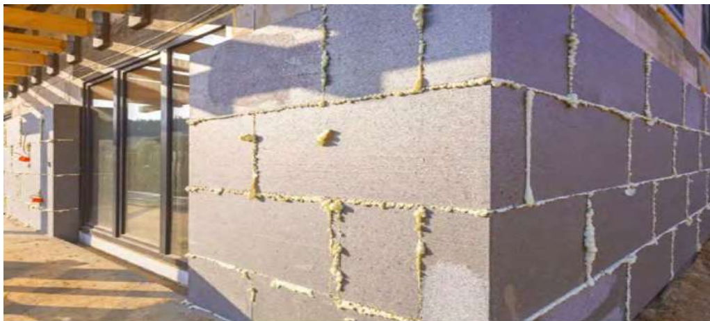
Pose d'isolant EPS Adam Matériaux en quinconce, soit de manière correcte
