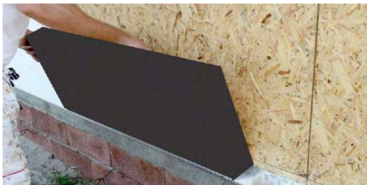
Collage EPS HD ADAM Matériaux avec de la mousse PUR Adam Matériaux sur façade en bois
