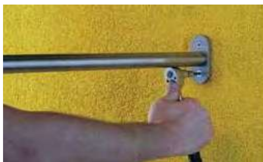
Pose de rambardes fixées aux blochets UMP après la pose du crépis
