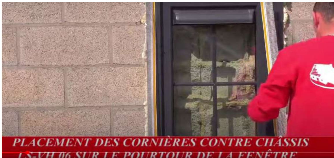
Pose de la cornière LS-VH 06 6mm à minimum 2cm du bord des dormant de la fenêtre
