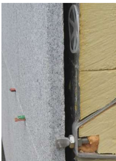
Pierre naturelle agrafée et isolant de socle pour le parachèvement du soubassement.
