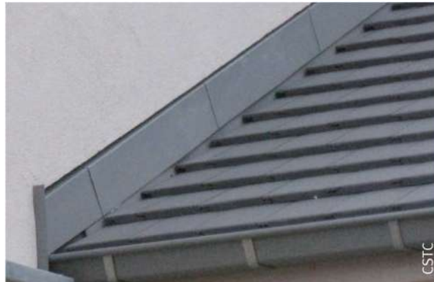
B. Vue après la pose de la couverture. Raccord de l'ETICS Adam Matériaux au départ d'une toiture à versants
