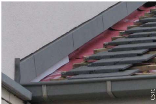
A. Vue avant la pose de la couverture de toiture
