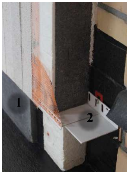
1- Plinthe encollée sur l'isolant de socle
