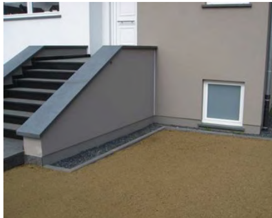
Muurvoeten behandeld volgens de constructieve bepalingen specifiek voor ETICS. Foto's hierboven: bronpagina 49 van de CSTC TIN 257
