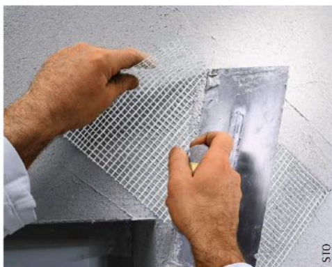
Versterkend Adam Matériaux wapeningsnet aanbrengen in een hoek van 300X300mm (MOUCHOIRS)
