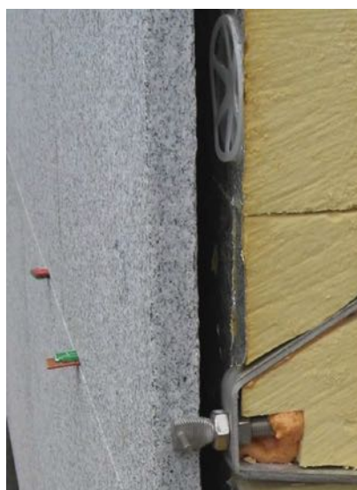
Geniete natuursteen en basisisolatie voor kelder afwerking.
