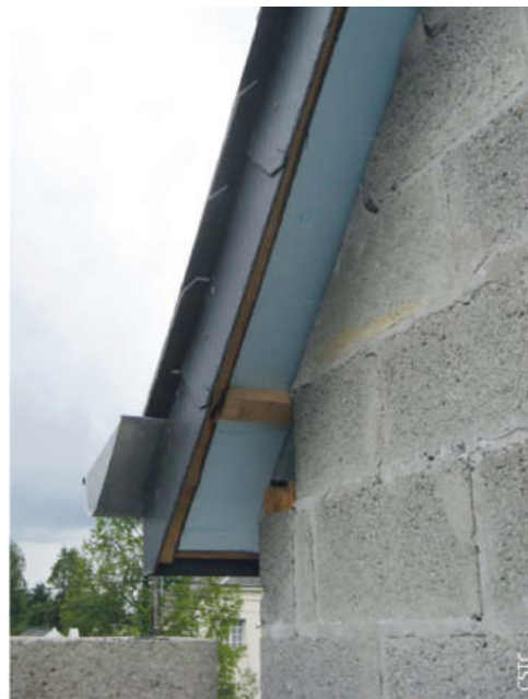
ETICS-verbinding met de helling van een hellingsdak (geval waar de ETICS aan het einde van de overschrijding komt)
