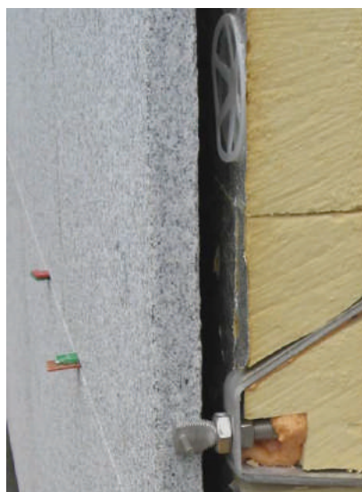
Geniete natuursteen en basisisolatie voor kelderafwerking.
