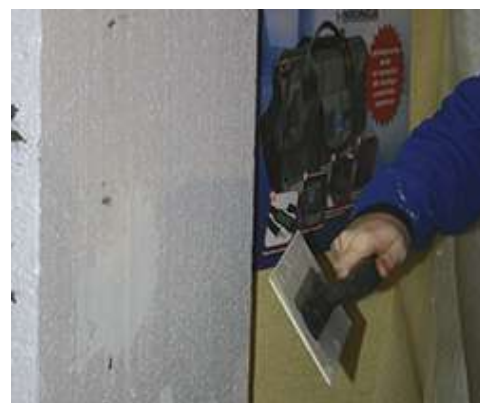
Dobijanie płyty styropianowej podczas instalacji
