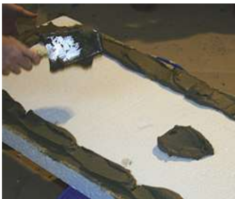
Mapetherm polystyreenlijm met een spatel op het paneel aanbrengen
