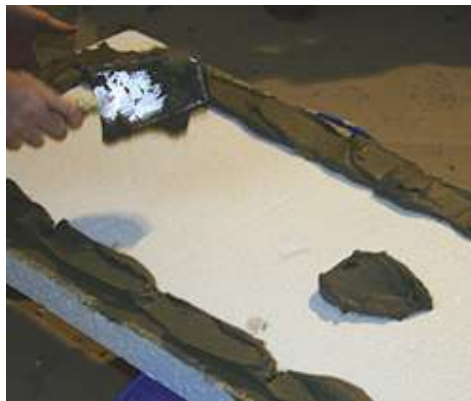
Mapetherm Polystyrolkleber mit einer Kelle auf die Platte auftragen
