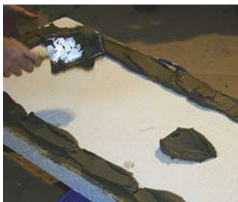
Nakładanie kleju Mapetherm do styropianu na płytę przy pomocy pacy
