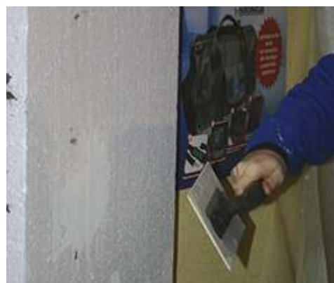
Enfoncer le panneau de polystyrène lors de l'installation
