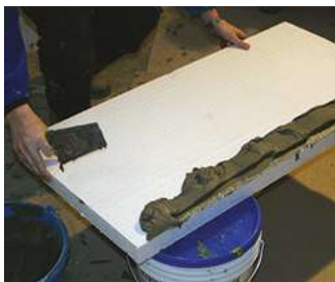
Application de la colle polystyrène Mapetherm sur le panneau isolant
