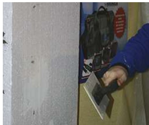
Druk het polystyreenpaneel tijdens de installatie aan
