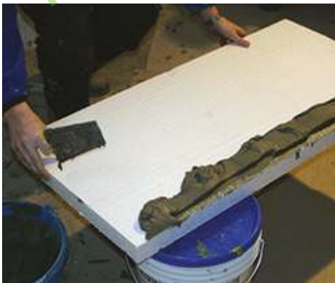
Auftragen von Mapetherm Polystyrolkleber auf die Dämmplatte
