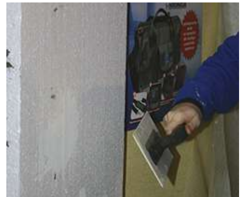
Beim Einbau die Polystyrolplatte andrücken
