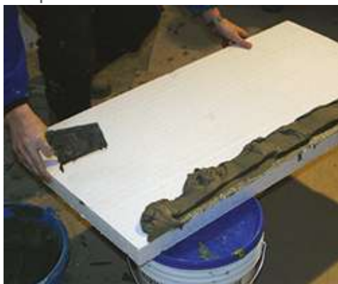
Aanbrengen van Mapetherm polystyreenlijm op het isolatiepaneel
