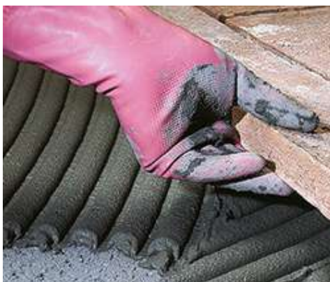
Układanie ręcznie wykonanej terakoty na nierównym podłożu
