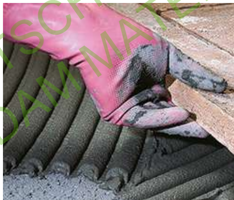
Verlegen von handwerklich hergestellter Terrakotta auf unebenem Untergrund
