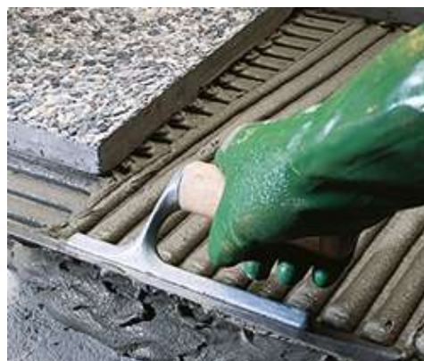
Montaż lastryko na zewnątrz
