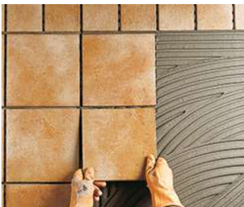
Montaż płytek klinkierowych na zewnątrz
