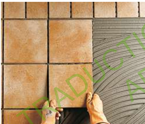
Pose de tuiles en clinker à l'extérieur
