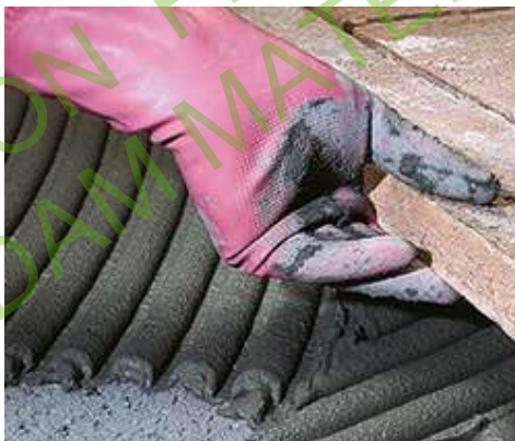
Pose de terre cuite artisanale sur une surface irrégulière
