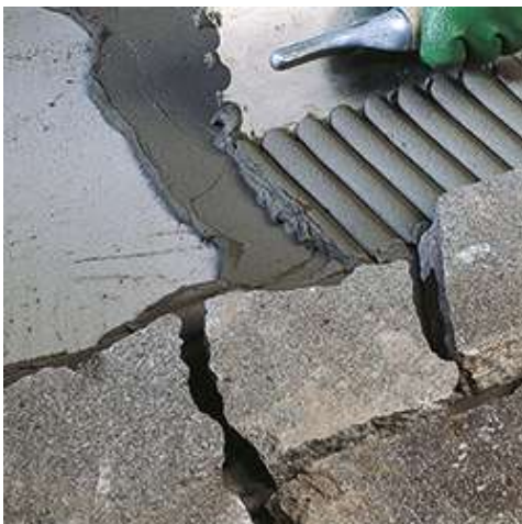
Pose de tuiles en clinker à l'extérieur
