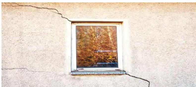
**Risse** um Fenster herum, die dadurch entstehen, dass Adam Matériaux EPS-Platten **nicht in L-Form** um Fenster herum platziert werden, **an den Ecken von Türen und Fenstern**
