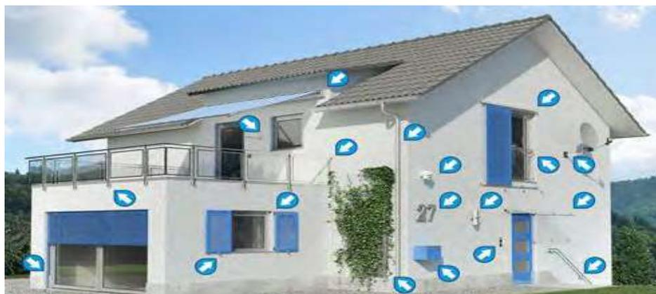
Nach dem Verkleben der Adam Matériaux EPS-Platten muss die Installation von **Blöcken** zur Befestigung der neuen Jalousien, Rollläden und Solarzelte nach den Arbeiten an der Adam Matériaux Etics-Fassade und dem Putzsystem geplant werden.
