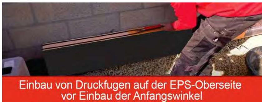
Einbau von **Kompribandverbindungen** vor dem Einbau der Startwinkel
