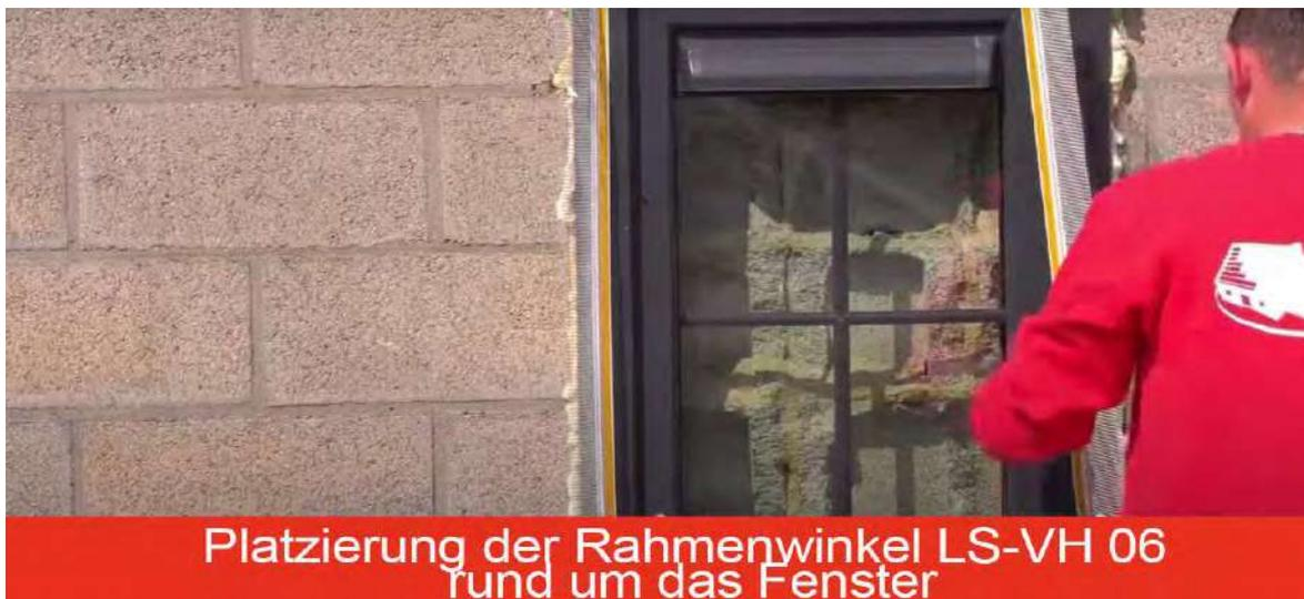
Montage des LS-VH 06 6mm Winkeleisens **mindestens 2cm vom Rand des Fensterrahmens entfernt**
