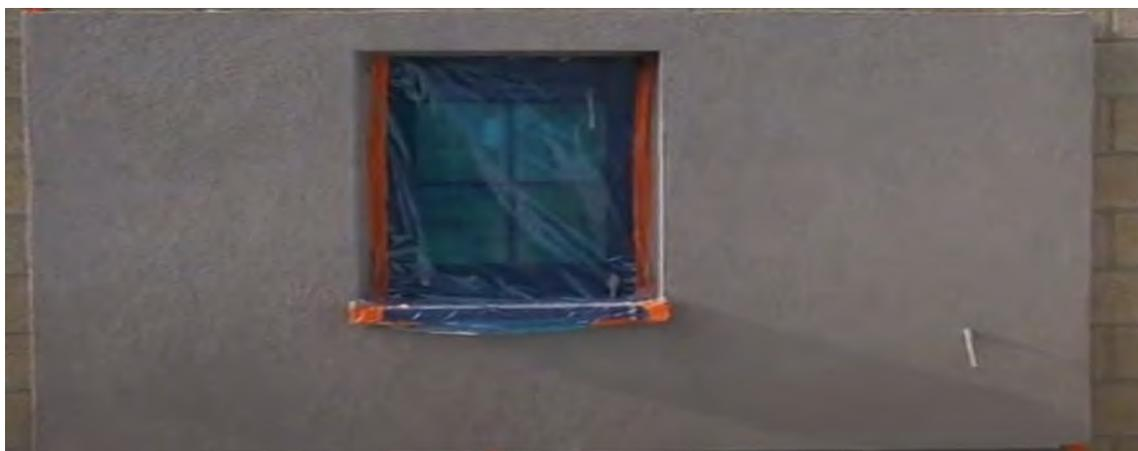
Es muss die **Entfernung von Chassis-Schutzvorrichtungen** wie dem **blauen Kunststoff** und dem **orangefarbenen** Klebeband geplant werden.
