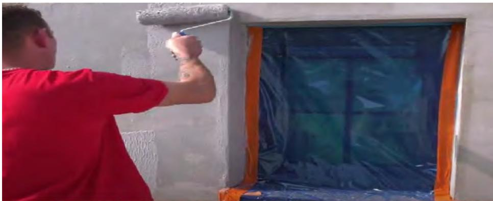
**Auftragen von Adam Matériaux Primer** auf eine Fassadenwand mit der **Rolle Kubala 4195 + Kubala 4112**
