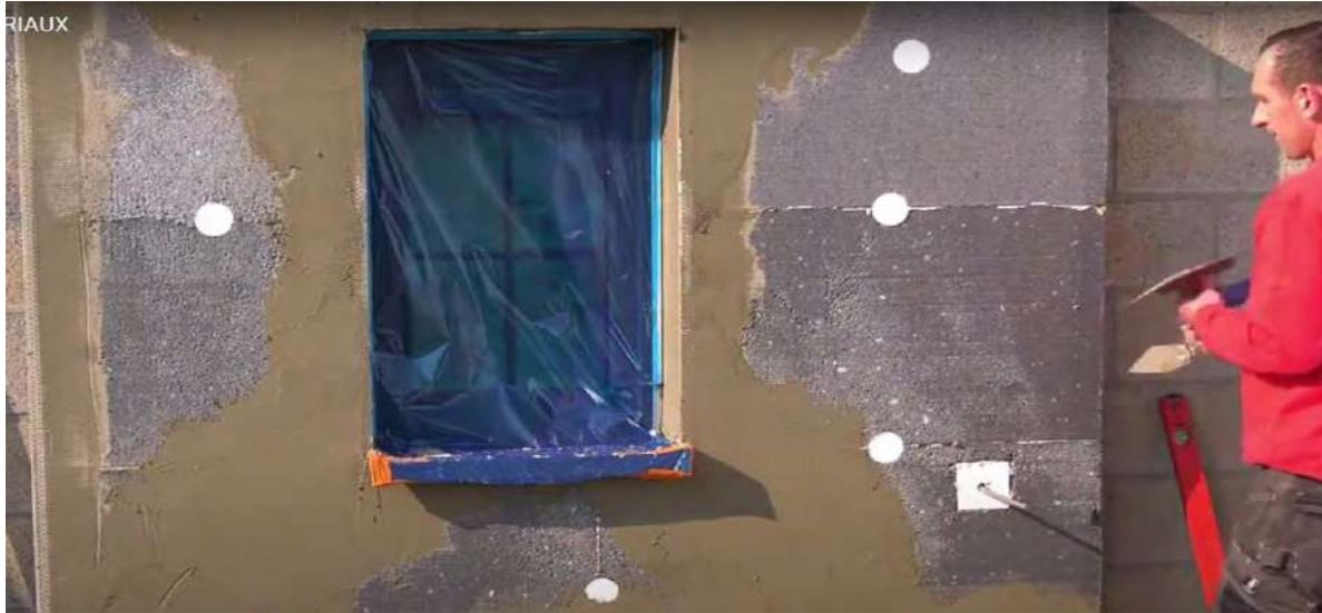
In die EPS-Dämmung von Adam Matériaux werden EPS-Stecker eingesetzt, **BEVOR** die „Verbände“ mit **grauem oder weißem Kleber** von Adam Matériaux angebracht werden.
