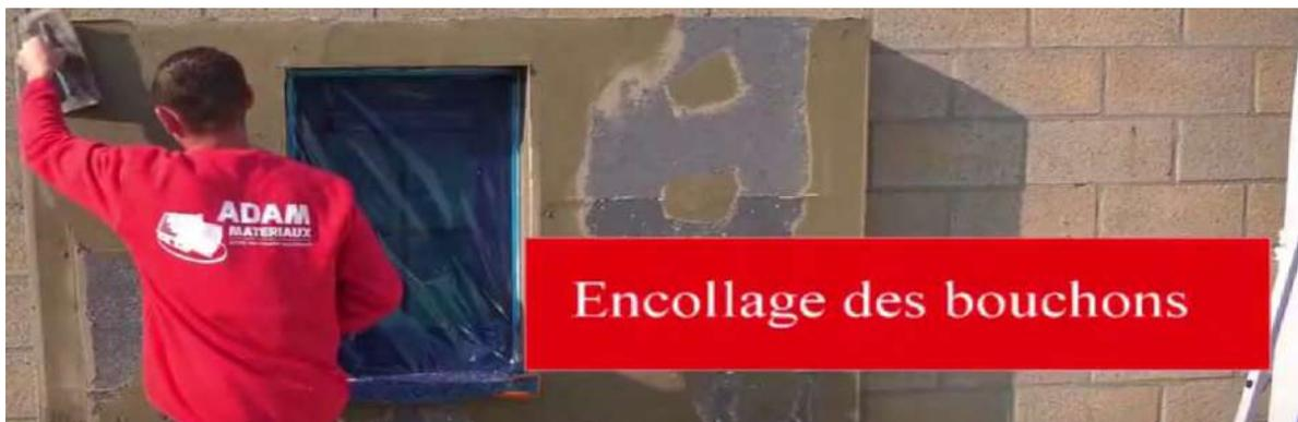
Anbringen von „Verbänden“ mit **grauem oder weißem Kleber** von Adam Matériaux zum Verschließen der EPS-Stecker, die so platziert sind, dass sie die Befestigungsdübel „ertrinken“.
