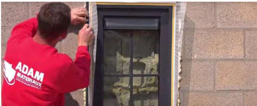
Montage des vorkomprimierten Dichtungsbandes (Kompriband) **Illmod TP600** auf den Festrahmen der Zargen neben den Winkeln LS-VH 06, **auf der Seite der Fassadendämmung**.
