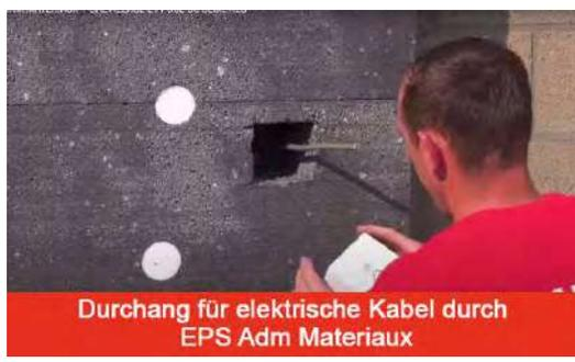
Entfernen des Adam Materiaux EPS um das Elektrokabel vor der Installation des **Variq- oder Varir-Blocks**
