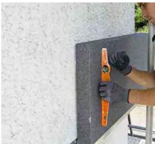
Verwenden einer **Wasserwaage** zum Verlegen von Adam Matériaux EPS
