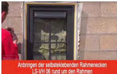
An den Seiten der Rahmen und den Ecken der Fassaden eignet sich der LK PVC 10x10cm Winkel gut oder der Winkel mit LK-VH Führung:
