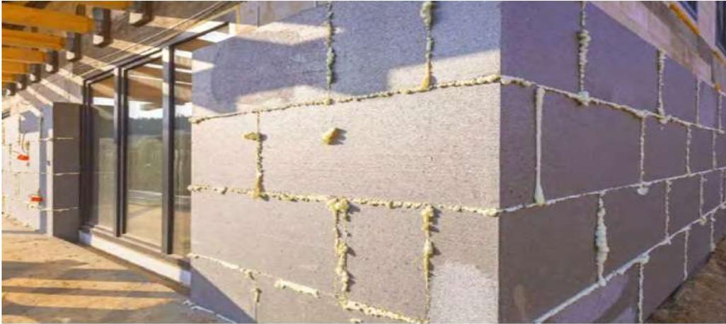
Verlegung der Adam Matériaux EPS-Dämmung versetzt, d.h. richtig
