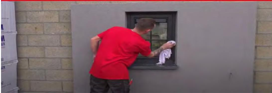
Nach der Reinigung der Rahmen muss der „**Haftverschluss**“ vom Winkeleisen LS-VH 06 6mm entfernt werden und bei korrekter Ausführung aller Arbeiten darf zwischen dem **Winkeleisen LS-VH 06 und dem Rahmen keine Silikonfuge** mehr angebracht werden.
