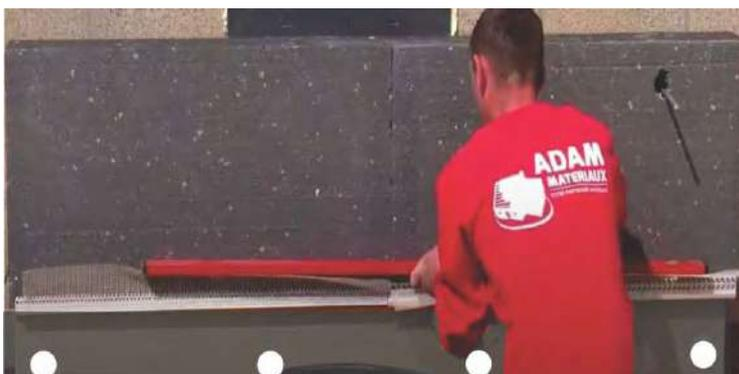
Installation der EPS 032 Adam Materiaux-Dämmung - EPS HD Adam Materialux
