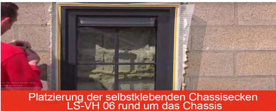
Montage der LS-VH 06 6mm Eckstücke **mindestens 2cm vom Rand des Fensterrahmens entfernt**
