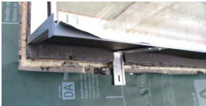
Verbindung zwischen einem Adam Materiaux ETICS und einem auf einem wärmedämmenden Baustein aufgesetzten Rahmen:
