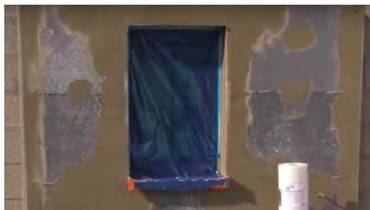
Dieselbe Technik gilt für die Montage der **LK PVC Premium 10x10cm Fassadeneckwinkel um Fenster und Türen**.
