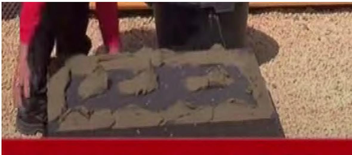
Verklebung von Adam Materiaux EPS **durch Pads**, die am weitesten **verbreitete Methode** **Empfehlungen zur Verklebung von Adam Matériaux EPS HD bei der Montage des Adam Matériaux Etics Fassaden- und Putzsystems**
