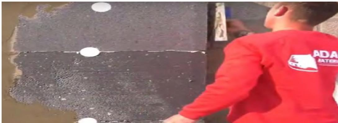
**Nach der Montage der Dübel und EPS-Dübel** muss **jeder EPS-Dübel aufgeklebt (verkleidet)** werden, d. h. jeder EPS-Dübel muss mit grauem oder weißem Kleber von Adam Matériaux verklebt werden, **bevor die HD EPS-Platten von Adam Matériaux beschichtet** werden.
