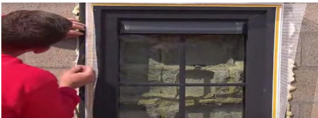
Montage des vorkomprimierten Dichtungsbandes (Kompriband) **Illmod TP600** auf den Festrahmen der Zargen neben den Winkeln LS-VH 06, **auf der Seite der Fassadendämmung**.
