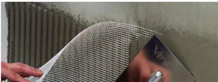
Das Netz von Adam Materiaux wird in den Kleber eingeklebt, der nivelliert wird, um eine ebene Oberfläche zu erhalten.
