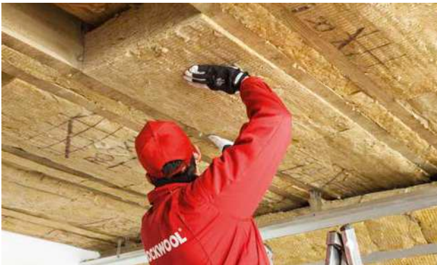
6. remplissez soigneusement les espaces entre les poutres
