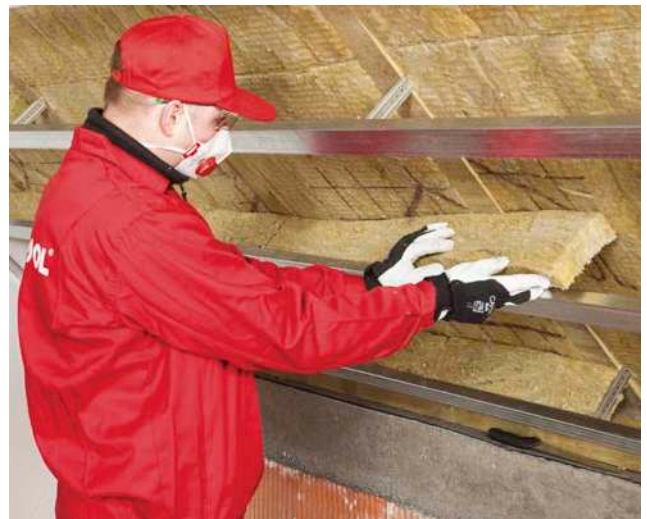
8. Remplissez les profils avec des bandes de laine
