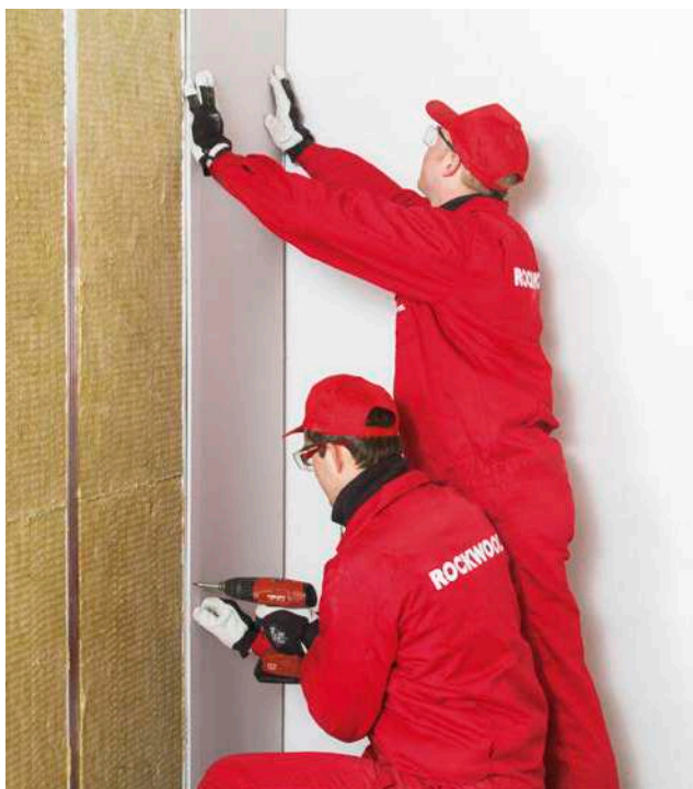
7. De l'autre côté du mur, attachez le revêtement
