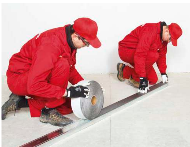
2. attacher un amortisseur insonorisant aux profils de périmètre
