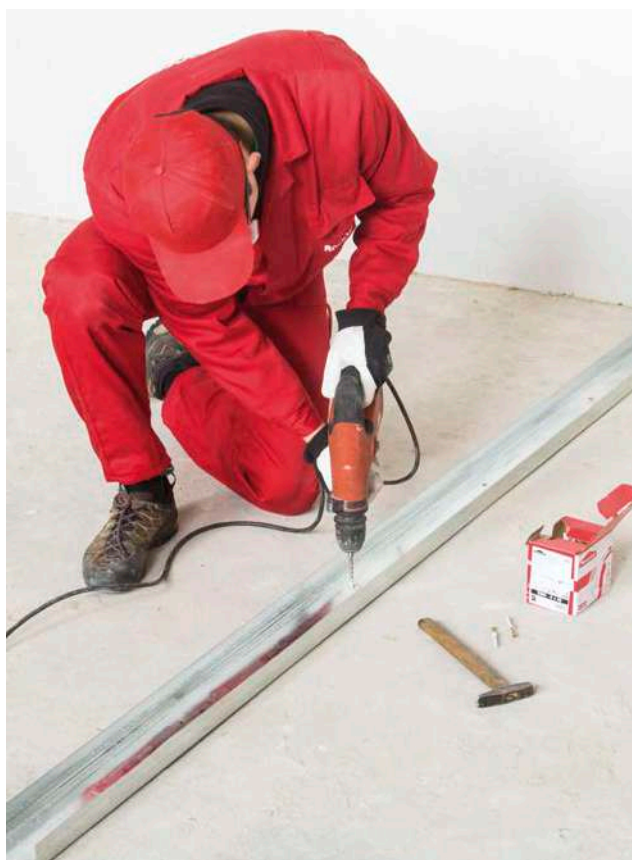
3. profils périphériques avec un tampon amortisseur fixé au plafond
