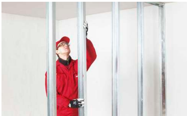
4. définir des piliers de construction verticaux
