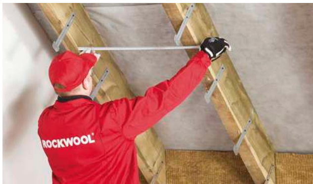
1. mesurer l'espacement dans la lumière entre les chevrons
