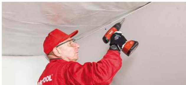
12. nous couvrons le revêtement avec des profils en métal
