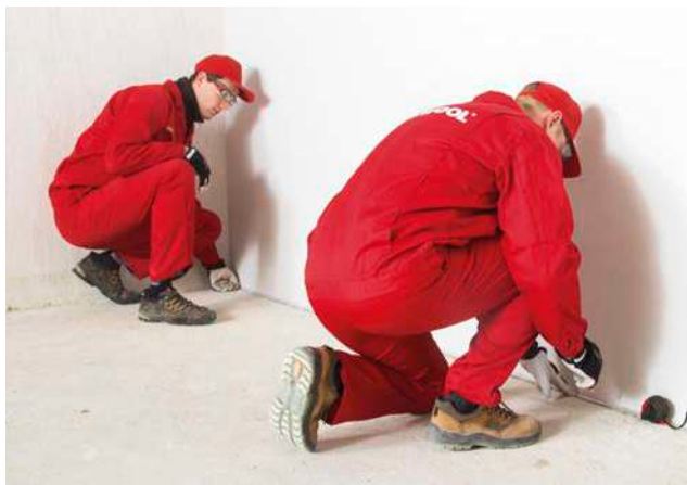
1. marquer l'endroit où le mur court
