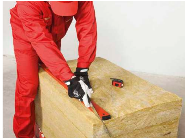
7. Nous découpons les bandes de laine à la largeur des profils
