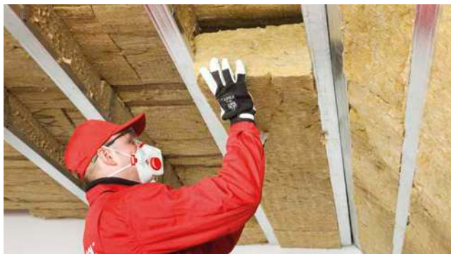
10. między profilami układamy ocieplenie z płyt SUPERROCK
