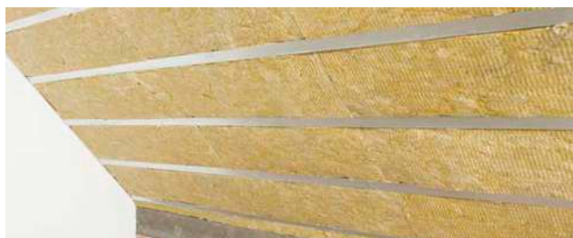
11. L'isolation correctement réalisée ne nécessite pas de fixation supplémentaire, p.ex. laçage
