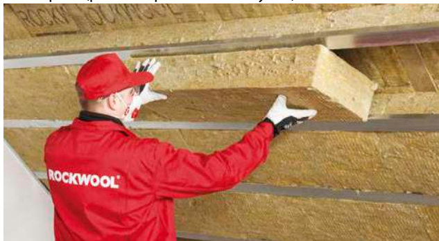
9. placer la deuxième couche d'isolant sous les chevrons
