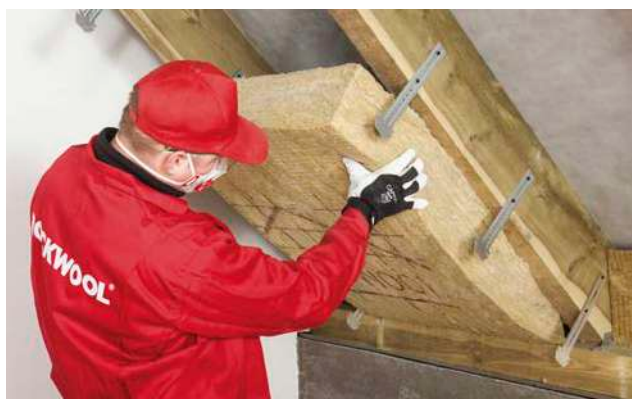
4. nous plaçons la première couche d'isolant entre les chevrons
