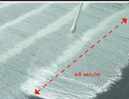
La vitesse de pulvérisation est de ± 4 secondes par mètre.
