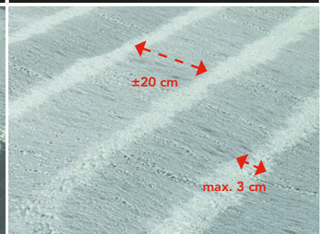
La largeur de pulvérisation optimale est de ± 20 cm, avec max. 3 cm de recouvrement entre les lignes de pulvérisation.
