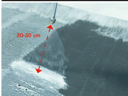
La distance idéale entre la surface et le pistolet de pulvérisation est comprise entre 20 cm et 30 cm.
