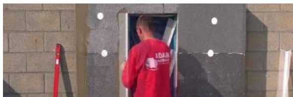
Przycięcie i montaż narożnika 10+10 cm na narożnikach okna, regulacja poziomu narożnika 10+10 cm
