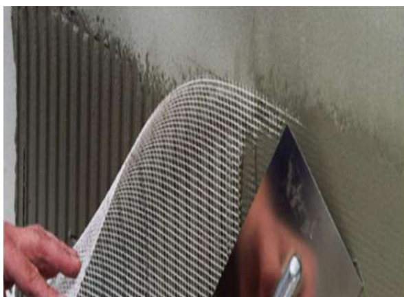
Wgniatanie siatki wzmacniającej Adam Materiaux w szary lub biały klej Adam Materiaux
