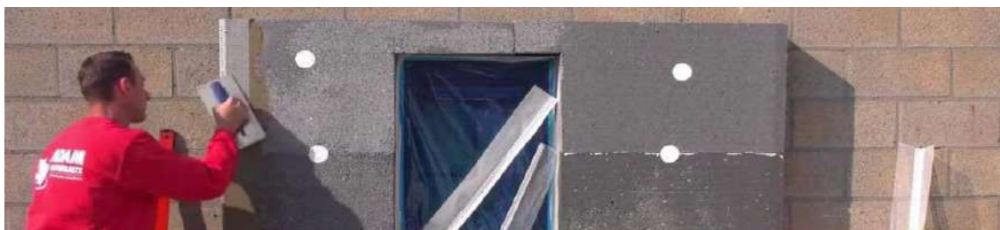
Mocowanie kątownika narożnego 10+10 cm za pomocą kleju Adam Materiaux
