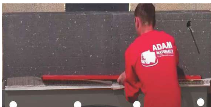
Montaż izolacji EPS 032 Adam Materiaux - EPS HD Adam Materiaux
