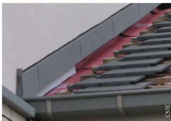
A. Widok przed położeniem pokrycia dachowego
