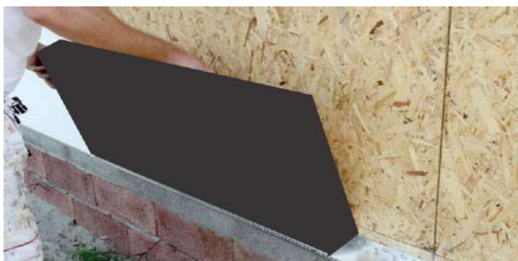
Colagem EPS HD da ADAM Materiaux com espuma PUR da Adam Materia em fachada de madeira
