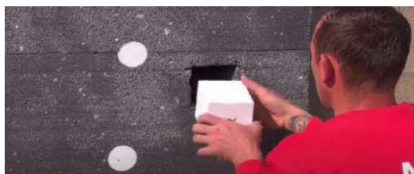
Passar um cabo elétrico pelo bloco EPS Adam Materiaux
