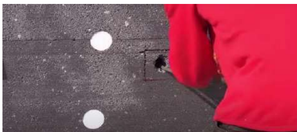
Instalação de bloco à medida para montagem de luminária, alarme, fixador, etc.
