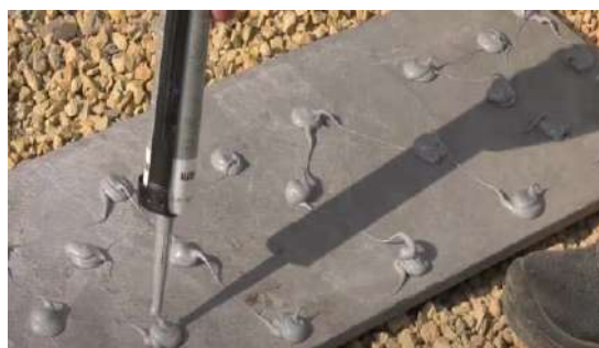
Instalação de almofadas de silicone de 2 componentes para colagem de pedra azul
