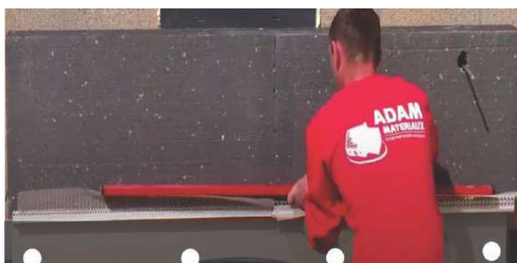
Instalação de isolamento EPS 032 Adam Materiaux - EPS HD Adam Materiaux
