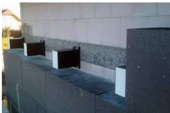
Instalação de guarda-corpos fixados aos blocos UMP após a colocação do reboco
