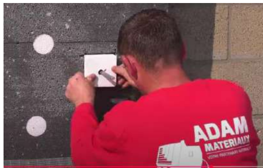
Instalação do bloco VARIQ ou VARIR
