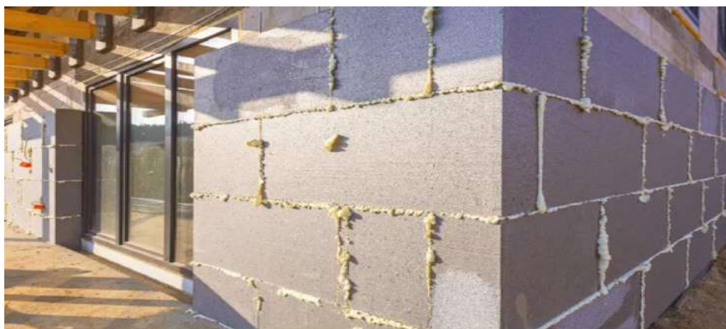
Instalação do isolamento EPS Adam Matériaux em padrão escalonado, da forma correta
