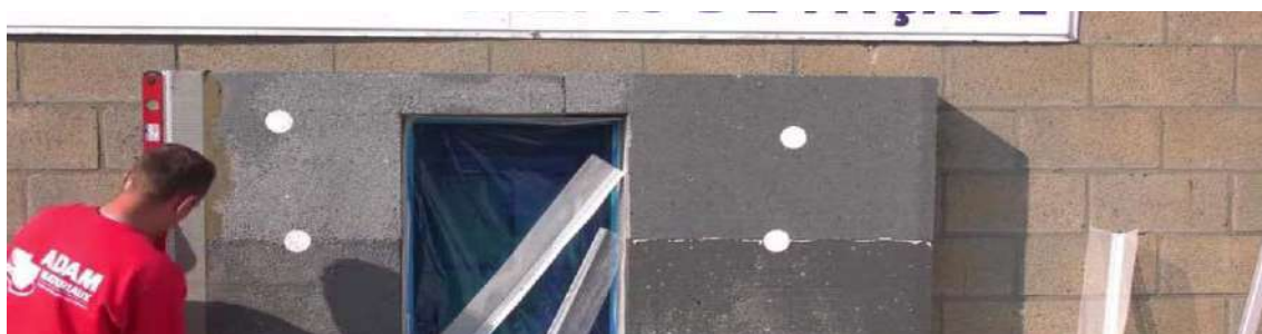
Ajuste da altura do suporte de canto 10+10 cm
