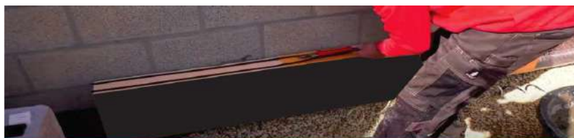
Montaż złączy ściskanych na wierzchu EPS przed montażem kątowników początkowych
