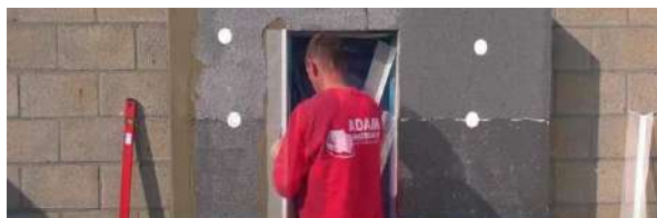
Cortar e instalar o canto de 10+10 cm nos cantos da janela, ajustando o nível do canto de 10+10 cm
