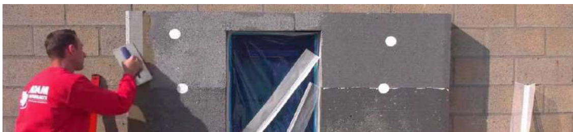
Fixação do ângulo de canto de 10+10 cm utilizando cola Adam Materiaux
