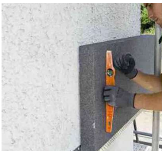
Usar um nível para colocar EPS Adam Matériaux
