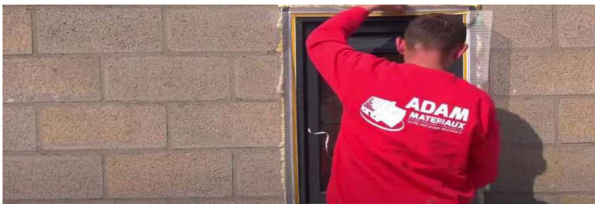
Disposição dos cantos da moldura do LS-VH 06 em redor da janela
