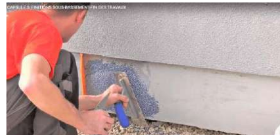
Instalação de gesso de cave Adam Materiaux
