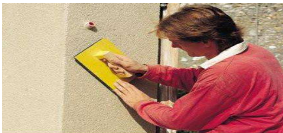
Canto de fachada SEM canto LC-L, com instalação de reboco no retorno e utilização do canto de canto LK-PVC Premium 10x10cm
