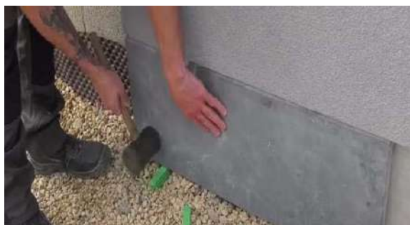
Ajustando os níveis de Bluestone
