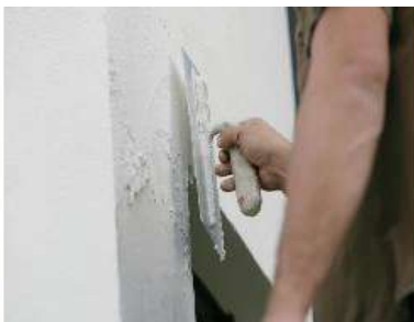
Aplicação de reboco com Kubala 0401 e 0473
