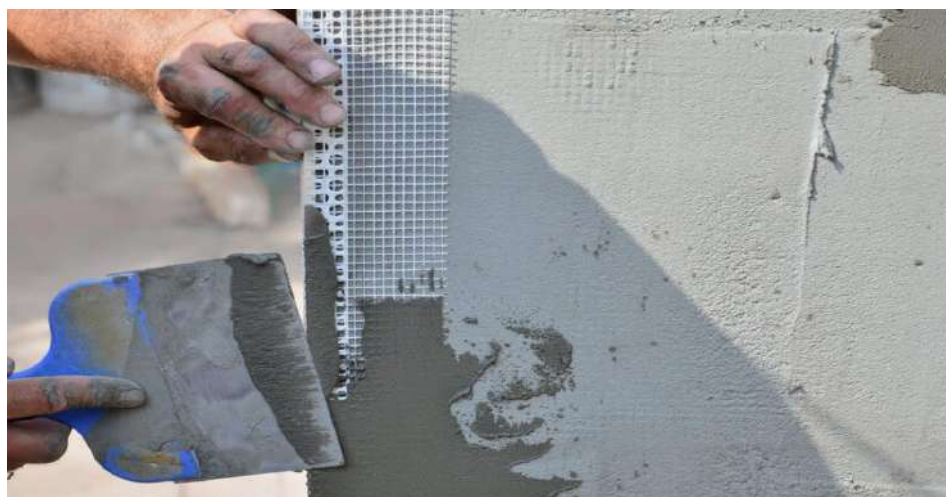
Ângulo de batente LCL colocado numa fachada antes da aplicação do reboco Adam Matériaux
