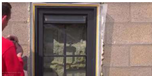
Colocação dos cantos do chassis autocolantes LS-VH 06 ao redor do chassis
