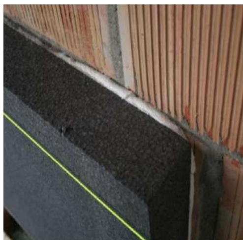
Usar uma corda para colocar EPS
