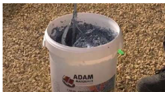
A obrigação de misturar o gesso antes de iniciar a obra
