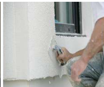
Aplicação de reboco com Kubala 0300
