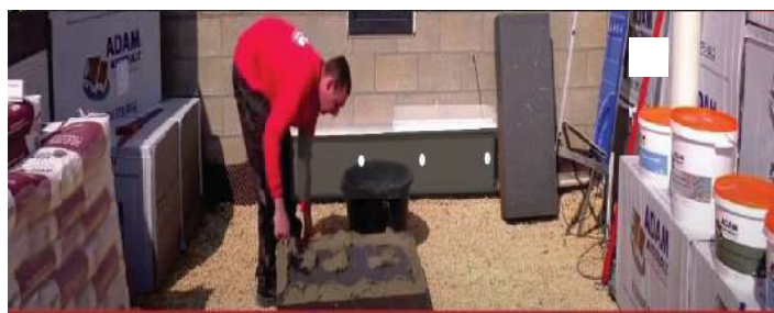
Aplicação de pastilhas adesivas Adam Materiaux cinzento de 10 em 10 cm no interior do isolamento
