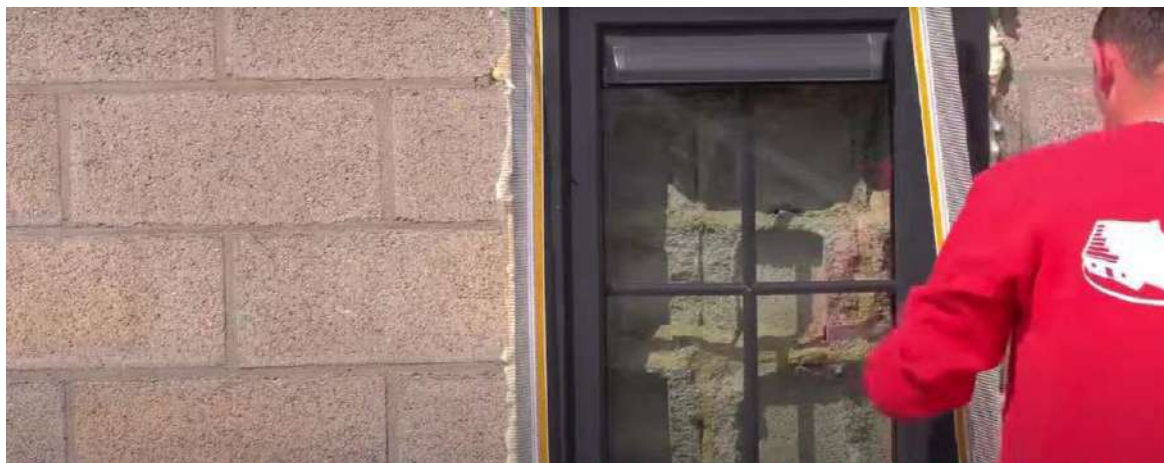
Disposição dos cantos da moldura do LS-VH 06 em redor da janela
