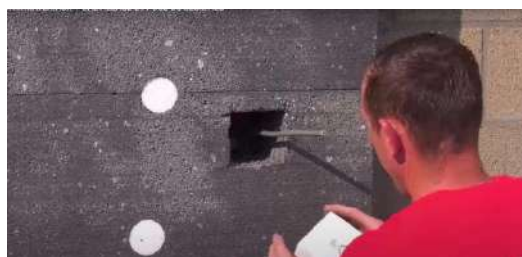
Passar um cabo elétrico pelo bloco EPS Adam Materiaux
