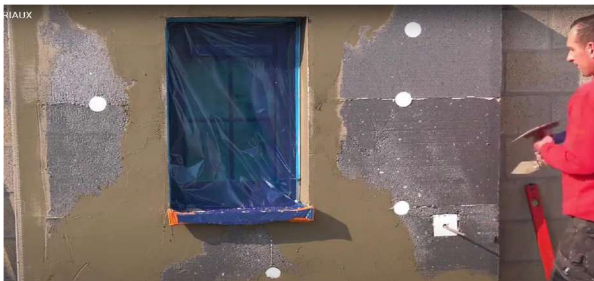
Tampões de EPS colocados no isolamento EPS Adam Matériaux ANTES da instalação das “ligaduras” com cola Adam Matériaux cinzenta ou branca.
