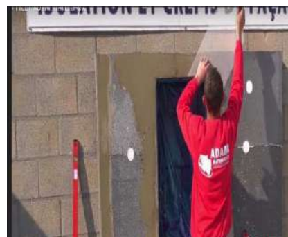
Colocação de tecido de reforço nos 4 cantos das armações, colagem com cola Adam Matériaux
