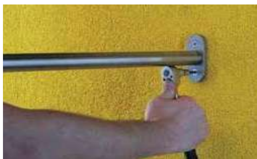
Instalação de guarda-corpos fixados aos blocos UMP após a colocação do reboco
