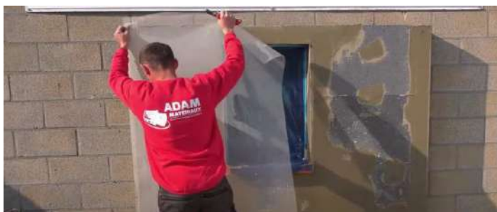
Corte e colocação de tiras de tela de reforço Adam Materiaux, mantendo uma sobreposição mínima de 10 cm entre as tiras
