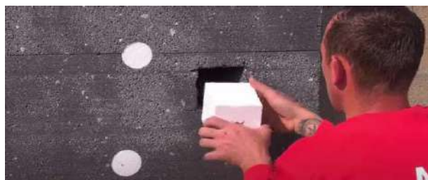
Trecerea cablului electric prin blocul EPS Adam Matériaux
