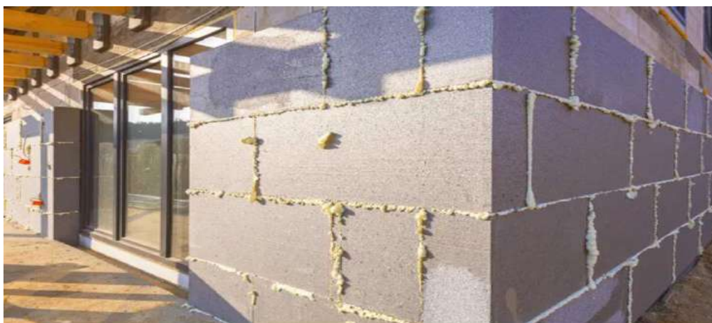
Instalarea izolației EPS Adam Matériaux într-un model eşalonat, în mod corect
