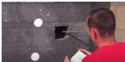
Trecerea cablului electric prin blocul EPS Adam Matériaux
