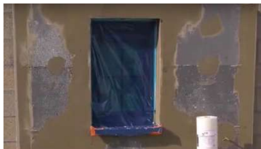
Tăierea și instalarea colțarului de 10+10 cm pe colțurile ferestrelor, reglarea nivelurilor colțarului de 10+10 cm
