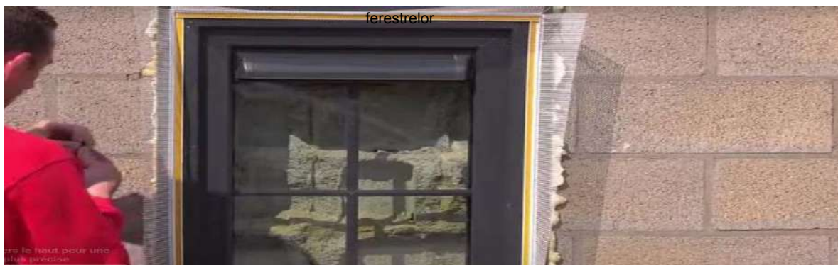
Placement des cornières contre chassis LS-VH 06 autocollantes sur le pourtour des chassis
