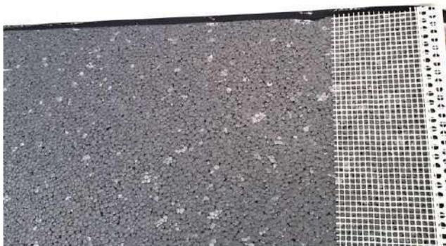
Ligação do reboco Etics e Adam Matériaux ao bordo do Etics de fachadas e reboco Adam Matériaux ao bordo da parte inferior da cobertura inclinada (caso em que o Etics entra em contacto com a saliência)
