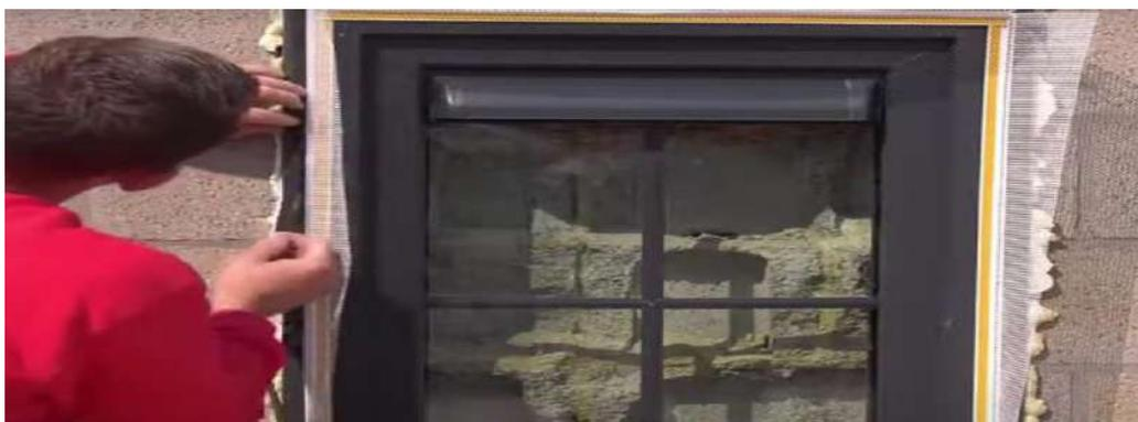
Instalação da faixa de vedação pré-comprimida (compribande) Illmod TP600 nas armações fixas dos caixilhos junto aos ângulos LS-VH 06, na lateral do isolamento da fachada.
