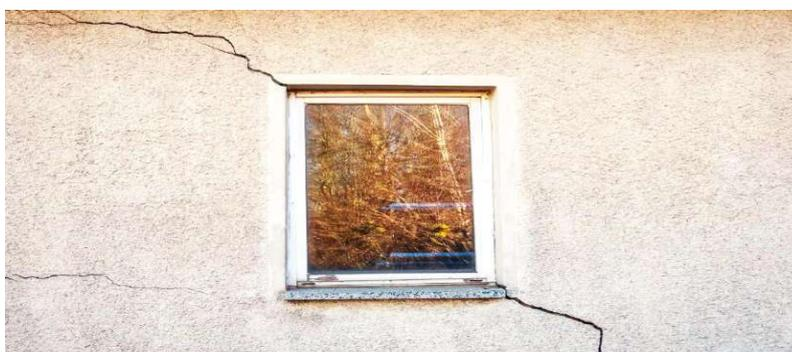
Fissuras em redor das janelas criadas pela não colocação dos painéis EPS da Adam Materiaux em forma de “L” em redor das janelas nos cantos das portas e janelas
