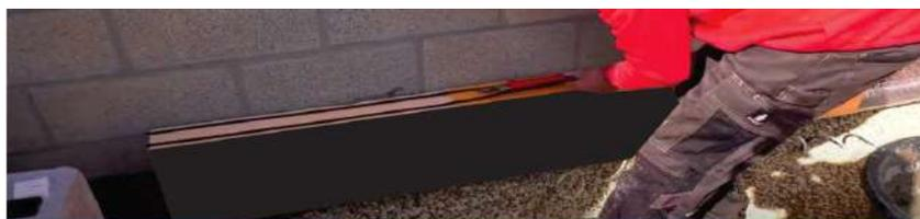
**Montaż złączy ściskanych na wierzchu EPS przed montażem kątowników początkowych**
