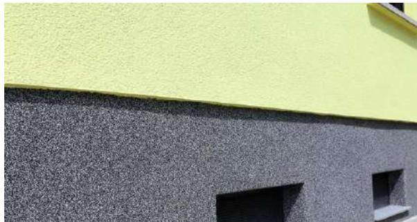
Pose de crépis de sous-bassement « M » Adam Matériaux avec un retrait du sous-bassement de minimum 2cm
