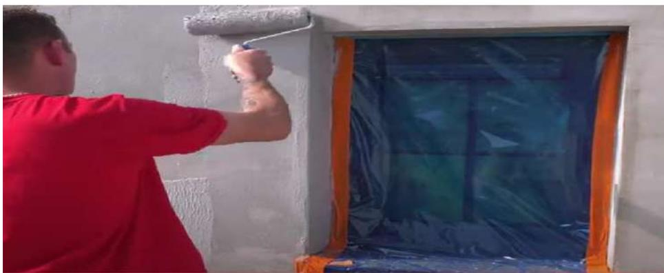
Aplicação de Primer Adam Matériaux em parede de fachada com rolo Kubala 4195 + Kubala 4112
