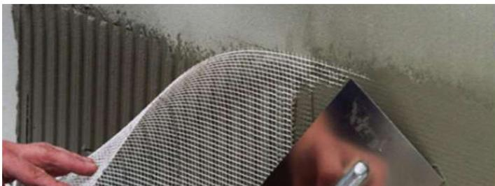
A malha Adam Materiaux é pressionada contra o adesivo, que é depois nivelado para criar uma superfície plana. O EPS HD Adam Materiaux é revestido e é instalada malha de reforço Adam Matériaux, com uma espessura de 3 a 6 mm por camada.
