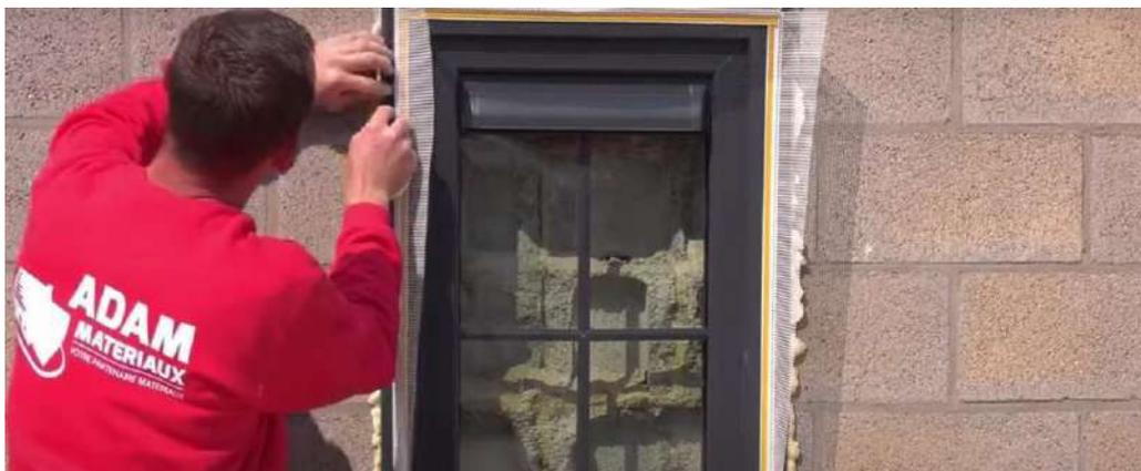
Instalação da faixa de vedação pré-comprimida (compribande) Illmod TP600 nas armações fixas dos caixilhos junto aos ângulos LS-VH 06, na lateral do isolamento da fachada.
