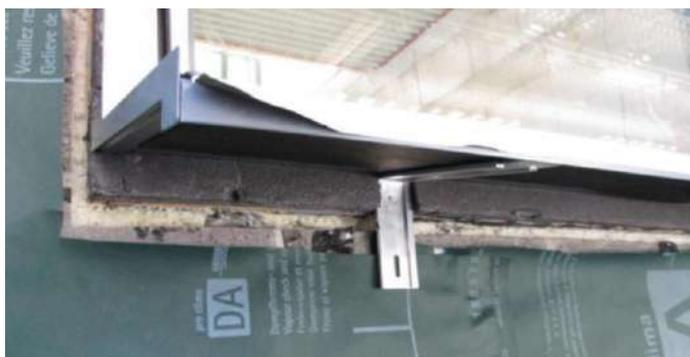
Ligação entre um ETICS da Adam Materiaux e uma estrutura colocada sobre um bloco de construção isolante térmico:
