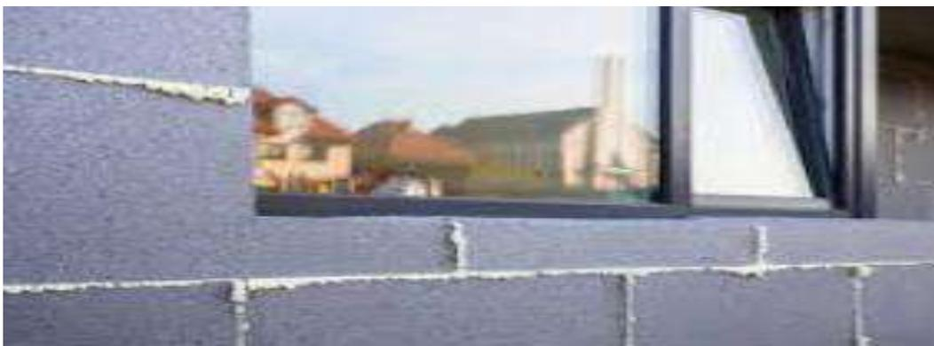
Se o instalador não respeitar a direção de colocação do Adam Matériaux EPS em redor das janelas e portas e nos ângulos iniciais, surgirão fissuras nas semanas ou meses seguintes à fachada Adam Matériaux e aos trabalhos de reboco:
