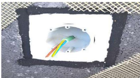
Caixa KEZ 301.01 colocada no sistema Etics da Adam Matériaux fachadas e reboco com selagem por compressão TP600 em todo o perímetro do bloco elétrico KEZ.
