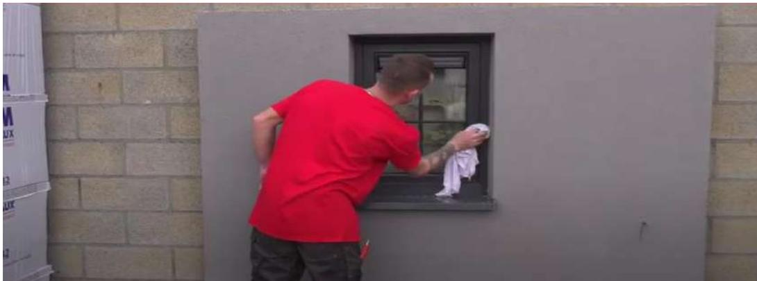
Após a limpeza dos quadros, o "stick" deve ser removido da cantoneira LS-VH 06 de 6 mm e, se todo o trabalho tiver sido executado corretamente, não será mais necessário colocar junta de silicone entre a cantoneira LS-VH 06 e o quadro.
