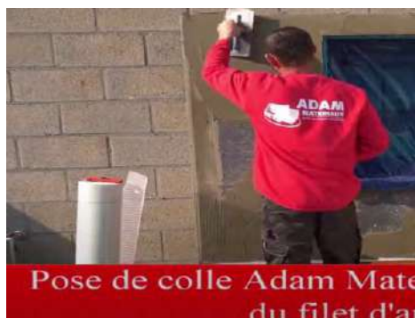
Utilisation de la plâtresse Kubala 0202 6x6mm
