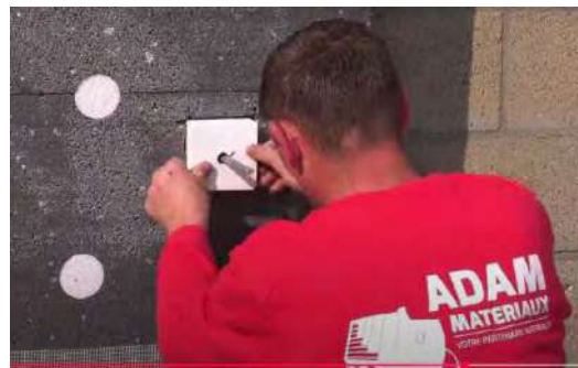
Pose du blochet VARIQ ou VARIR
