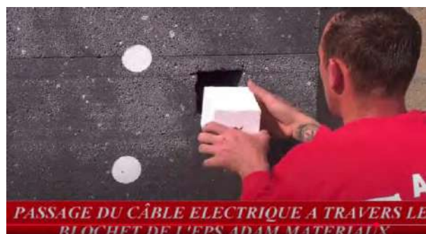
Pose du blochet VARIQ ou VARIR
