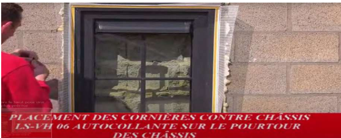
Pose des cornière LS-VH 06 6mm à minimum 2cm du bord des dormant de la fenêtre
