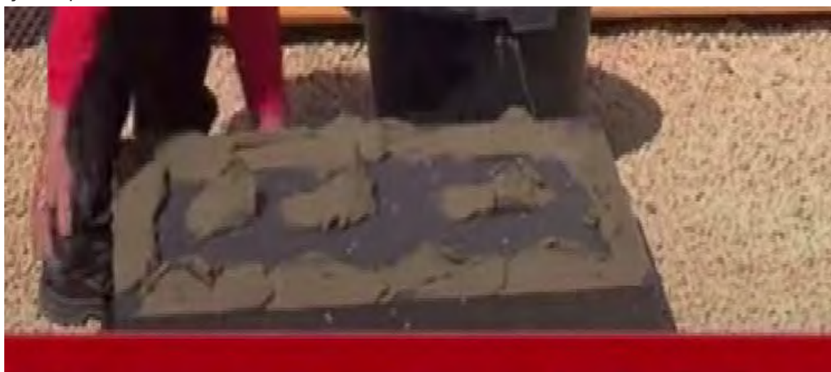
Collage par plots de l'EPS Adam Matériaux, méthode la plus utilisée
