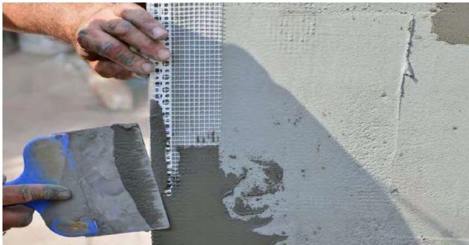
An einer Fassade angebrachter LCL-Anschlagwinkel vor dem Auftragen des Adam Matériaux-Putzes
