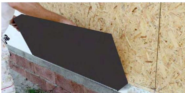
ADAM Materiaux EPS HD-Collage mit Adam Materiaux PUR- Schaum auf Holzfassade
