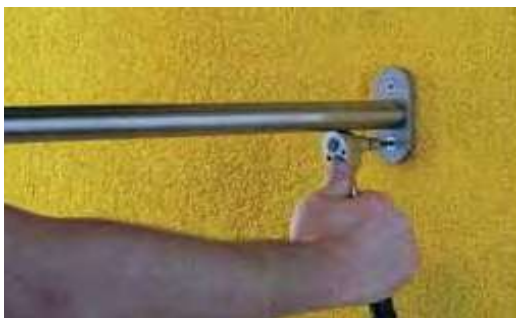
Montage von an den UMP-Blöcken befestigten Geländern nach dem Verlegen des Putzes
