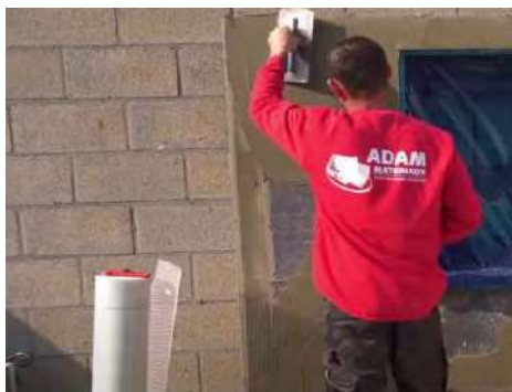
Verwendung von Kubala 0202 6x6mm Gips
