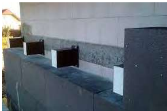
Montage von an den UMP-Blöcken befestigten Geländern nach dem Verlegen des Putzes
