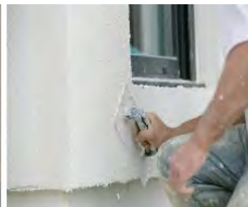
Putzauftrag mit Kubala 0300
