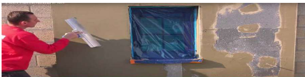
Auftragen von Adam Materiaux Kleber auf das Adam Materiaux Verstärkungsnetz
