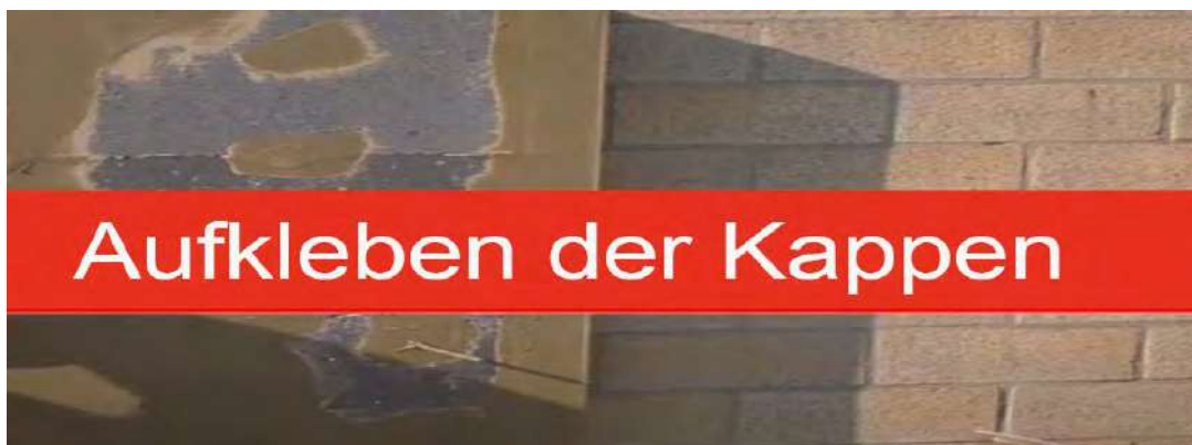
Aufkleben der Kappen vor dem Beschichten der Adam Materiaux HD EPS-Platten
