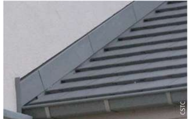
B. Vue après la pose de la couverture.
