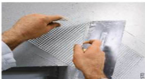
- Pose d'un filet d'armature Adam Matériaux de renfort dans l'angle d'une baie 300X300mm (MOUCHOIRS)
